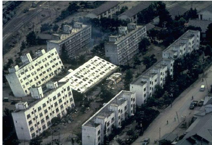
Figure 1.1- Basculement des bâtiments d'habitation de Kawagishicho à Niigata au Japon 1964 [12].
