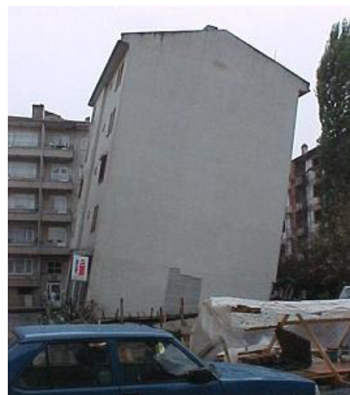
Figure 1.17- (a) Schéma de Tassement, (b) Modes de tassement des bâtiments robustes et élancés à Adapazari séisme de Kocaeli 1999 [24].
