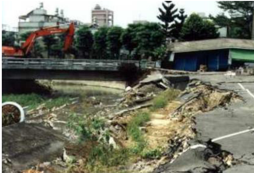
Figure 1.5- Dommages dus au glissement de terrain, Séisme de Chi-Chi, Taiwan (1999) [2].
