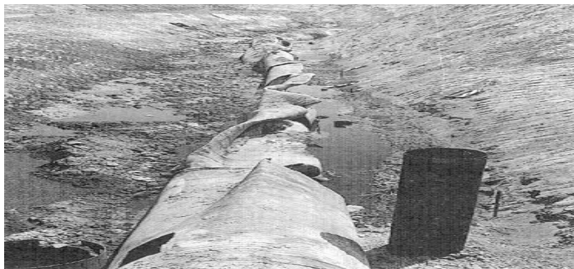
Figure 1.6- Soulèvement des réseaux enterrés, Séisme de Northridge 1994 [16].
