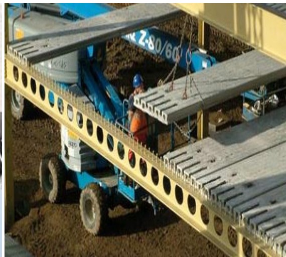
Figure 1.2: Poutre mixte à âme ajourée . [4]
