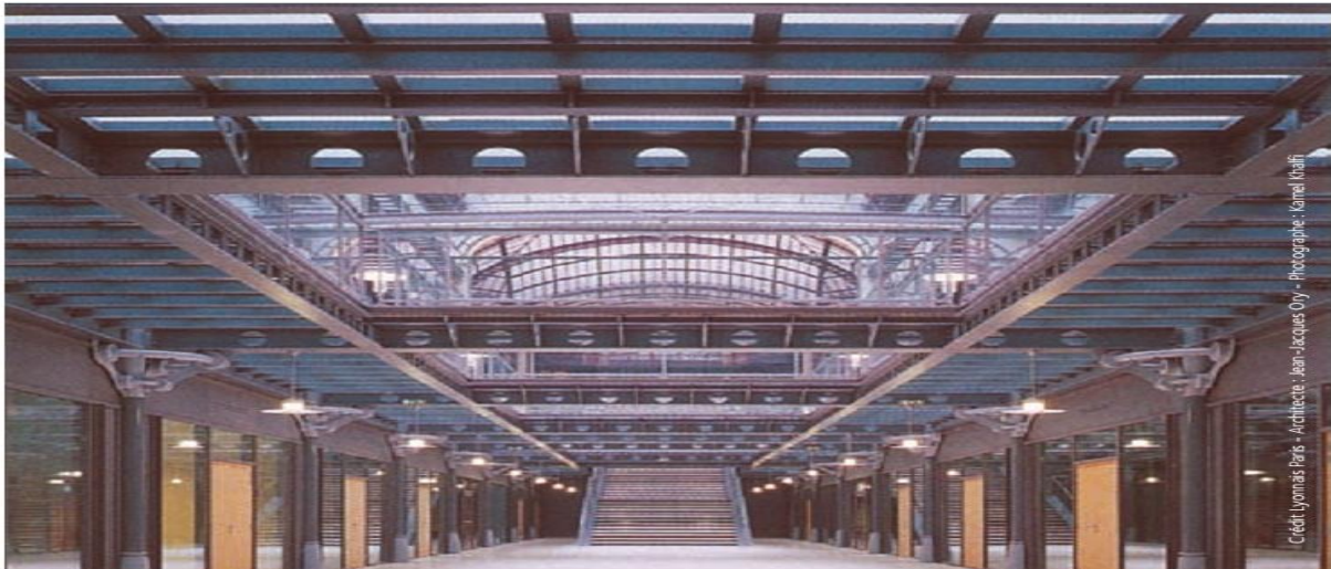
Figure 7.9: Rénovation à l'aide de poutrelles cellulaires ACB®.
