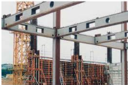
Figure 5.1 : Poutres à ouvertures d'âme traditionnelle.
