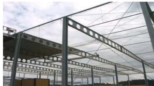
Figure 7.3 : poutres à inertie variable.
