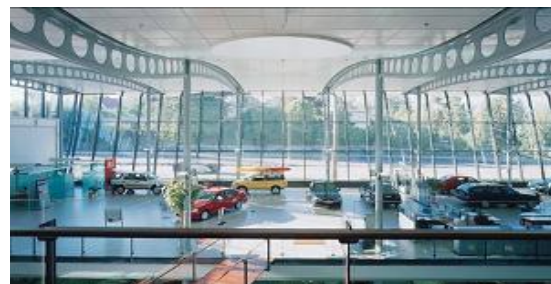
Figure 7.5 : Structure de toit avec des poutres cellulaires cintrées
