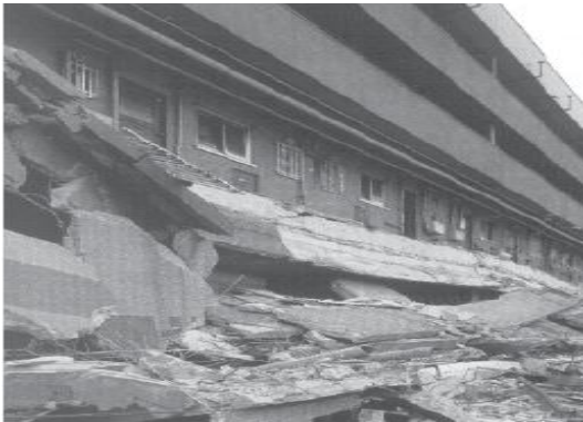
Figure 1.33: effondrement des coursives en porte-à-faux, séisme de Kobé, en Japon (1995)
