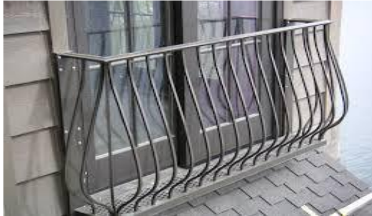
Figure 1.3 : un faux balcon
