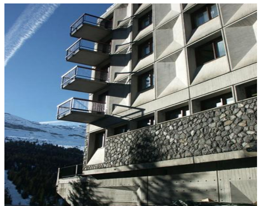
Figure 1.15 : des balcons "plongeoir" de l'hôtel Le Flaine
