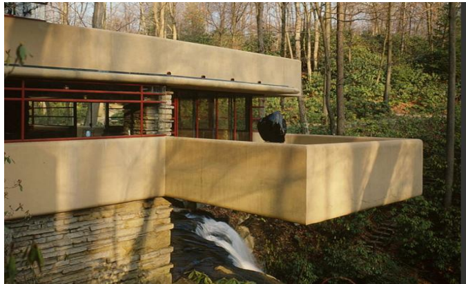
Figure 1.5 : terrasse en porte-a faux de la maison de cascade
