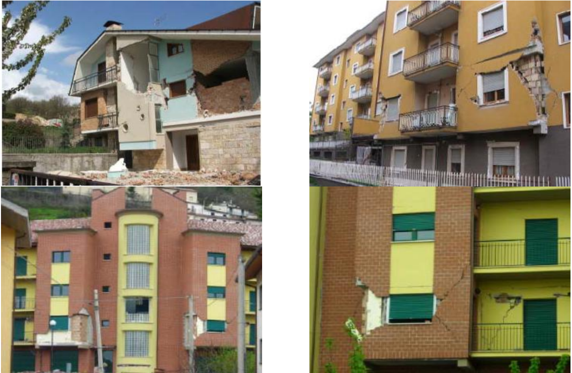
Figure 1.35 : Effondrements des structures en béton armé, en maçonnerie, et des éléments non structuraux, séisme de L'Aquila (2009).
