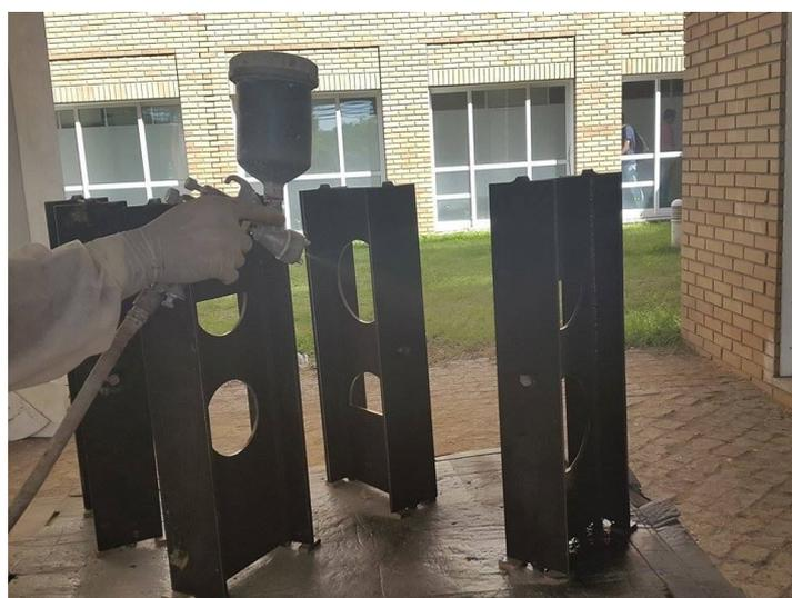
**Figure 4.3.** Application du primer et anticorrosion
