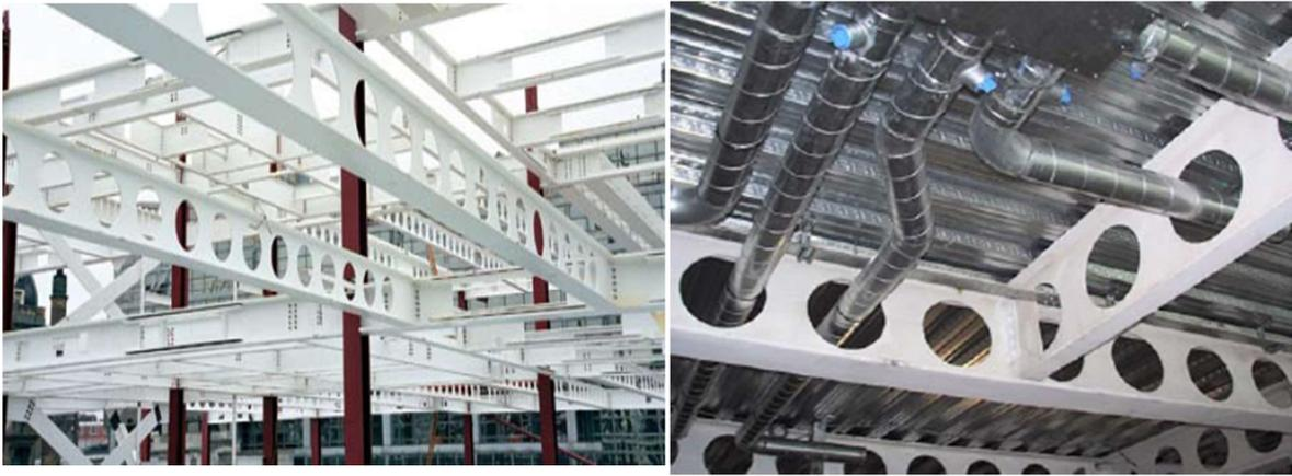
**Figure 1.1.** Structure à poutres ajourées [8,9,15], poutres cellulaires ACB protégées par peinture intumescente.
