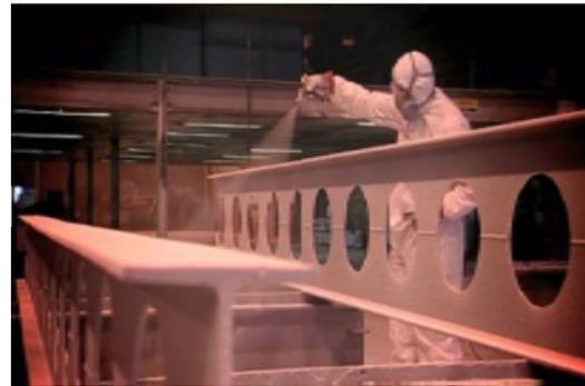
**Figure 1.31.** Couches de traitement avant et après application du revêtement intumescent, Application de la protection pour une poutre cellulaire [AkzoNobel].
