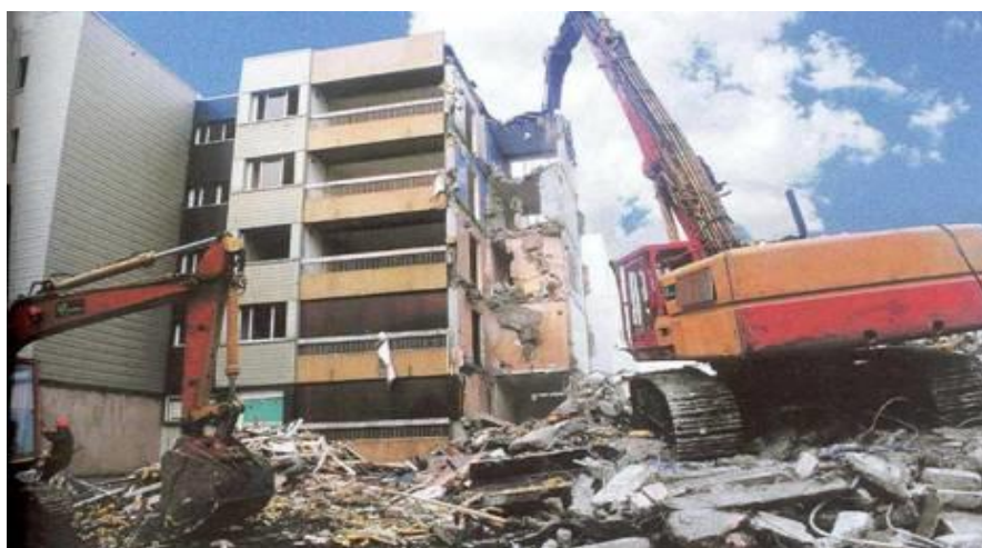
Figure 1.2 : Démolition d'une construction (problème de débris).
