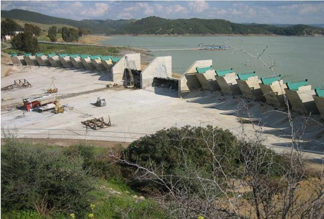
**Photo.7.1.** Hausses fusibles du barrage Ghrib (*Hydroplus*)
