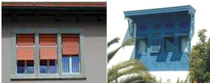
**Figure I.8 Protections solaires extérieures mobiles (GUIDE-PRATIQUE 2010)**
