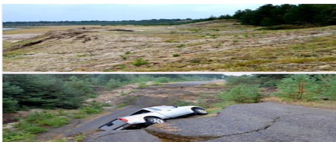
**Figure 1.4** : Apparition de liquéfaction au cours de séisme de Lausitzer, Allemagne, (2013).
