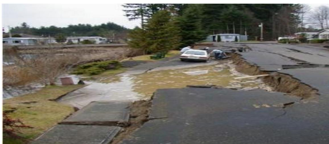
**Figure 1.3** : Phénomène de liquéfaction induit par le séisme de Washington, USA, (2001).
