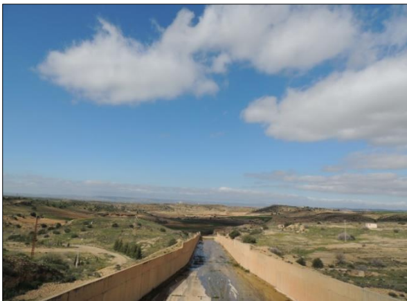
e) Ouvrage de rejet.
