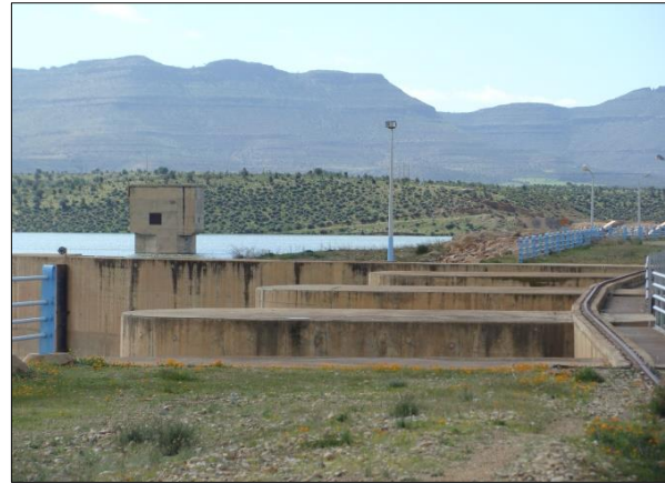
d) Evacuateur de crues à seuil vanné
