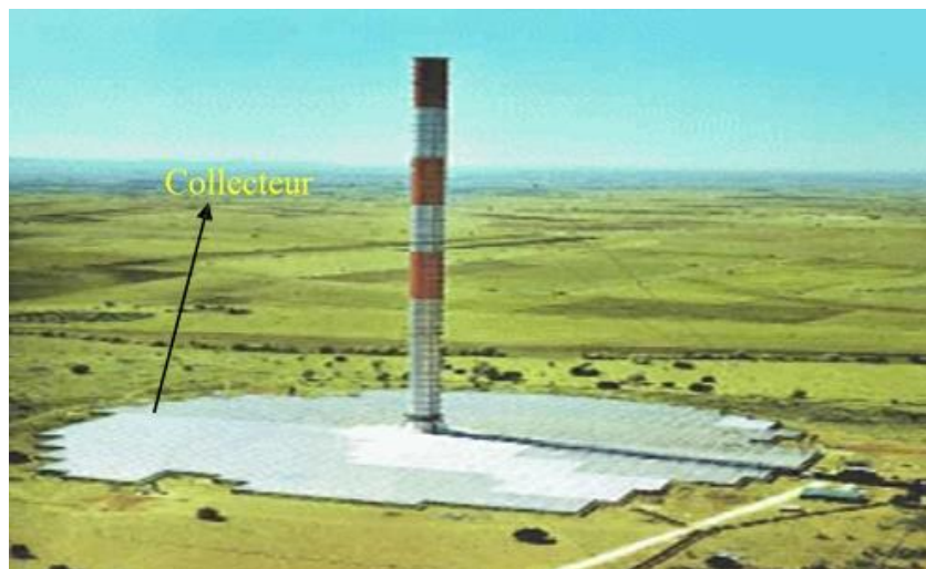
Fig. I.2 : La Centrale à cheminée solaire de Manzanares en Espagne
