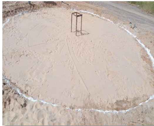
Fig. III.12 : Couche de sable 0.05 m
