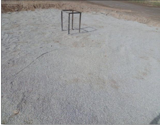
Fig. III.11 : Couche de 0.05 m de gravier
