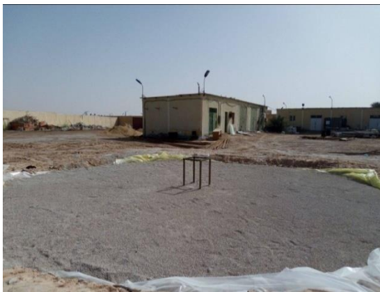
Fig. III.15 : Couche de gravier 0.1 m
