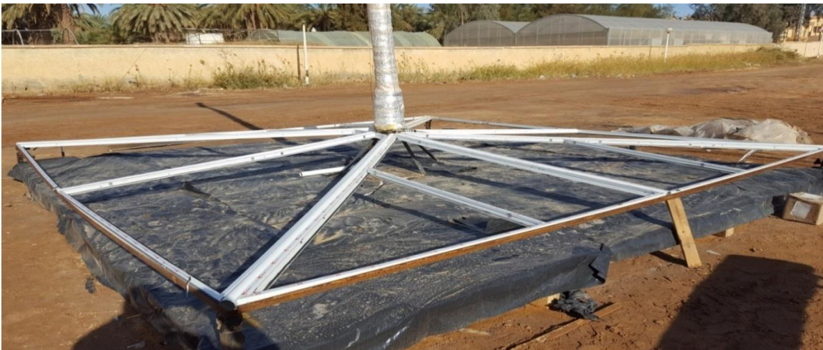
Fig. III.6 : Préparation d'emplacement de couverture en verre
