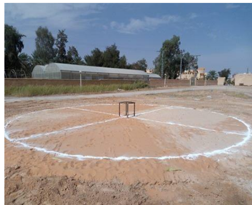
Fig. III.16 : Couche de sable 0.1 m
