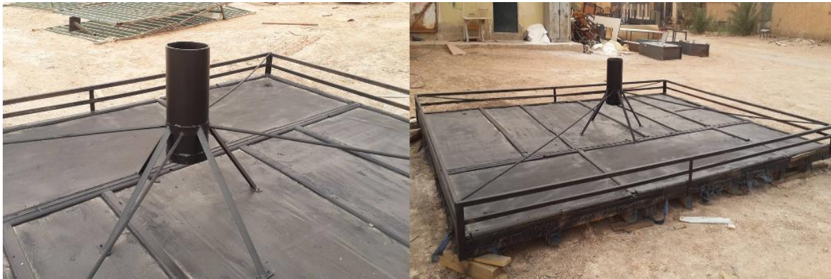
Fig. III.2 : Fondation de Collecteur utilisée en bois
