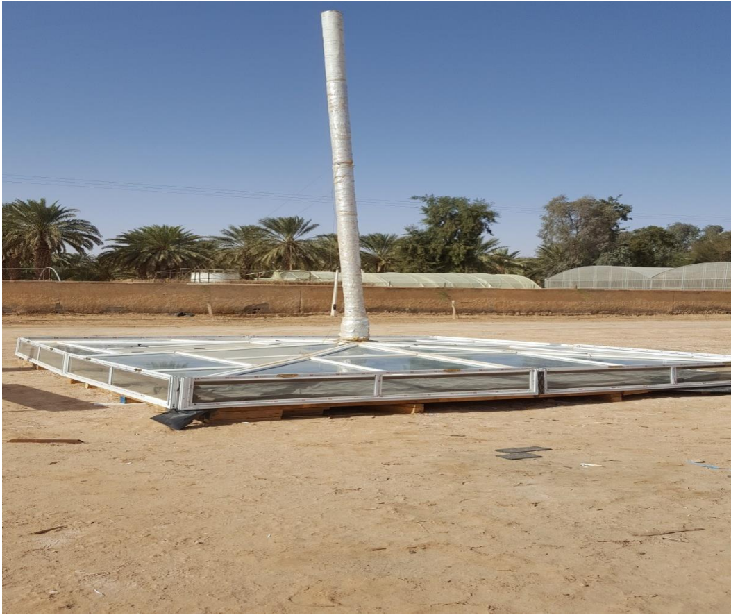
Fig. III.10 : Vue générale du prototype cheminée solaire n°2
