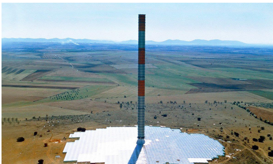
Fig. I.17 : Projet Centrale cheminée solaire de Manzanares en Espagne
