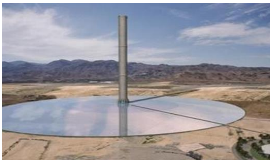
Fig. I.3 : Image générée par ordinateur d'une centrale à cheminée solaire à grande échelle proposée par Schlaich Bergermann und Partner, 2006.[8]
