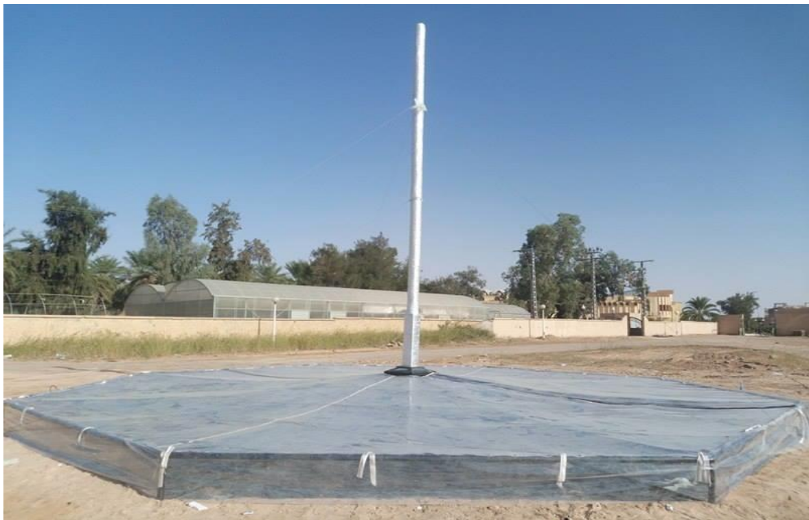
Fig. III.20 : Vue générale du prototype cheminée solaire n°3
