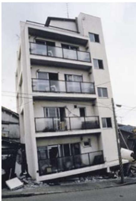
**Figure 1.11:** rez-de-chaussée effondré entièrement. Murs en béton armé- Great Hanshin, Japon 1995 / Kobe (Götz, 2003)
