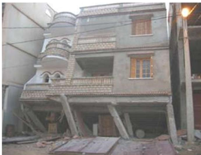
Figure 5.3: Bâtiment existant étudié, sans murs de remplissage en façade, au niveau du RDC
