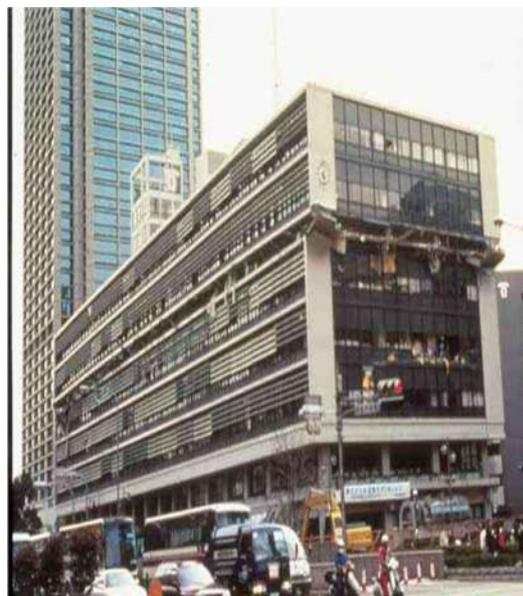
**Figure 1.18:** effondrement d'un étage de la mairie de Kobe (Séisme de Kobe en 1995)
