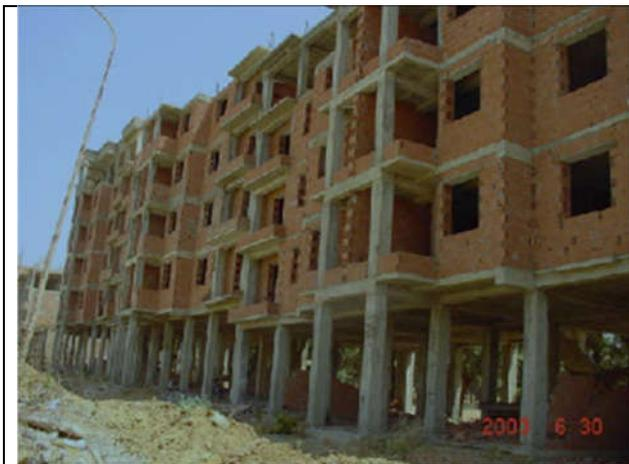
**Figure 1:** Exemple typique de bâtiment en Algérie avec étage souple
