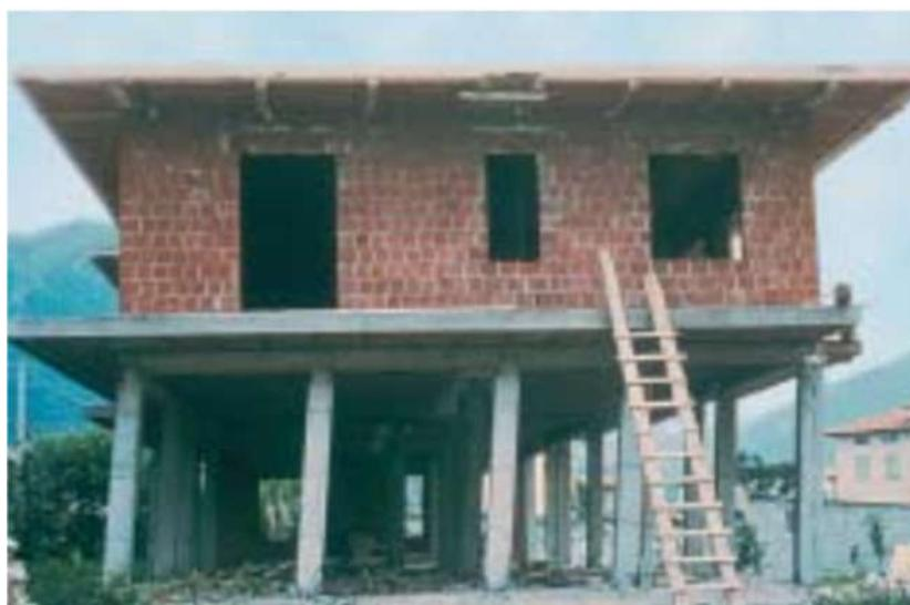
**Figure 1.13:** Mécanisme de ruine des poteaux d l'étage souple (Frioul, Italie, 1976)- (Bachmann, 2002).
