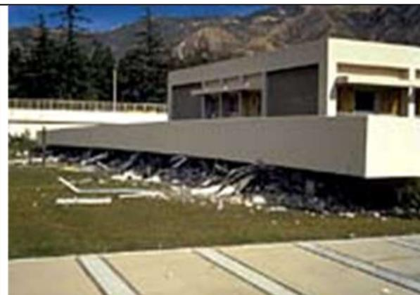
**Figure 1.14:** Etage faible au RDC, Hôpital San Fernando, La Californie (séisme, 1971)
