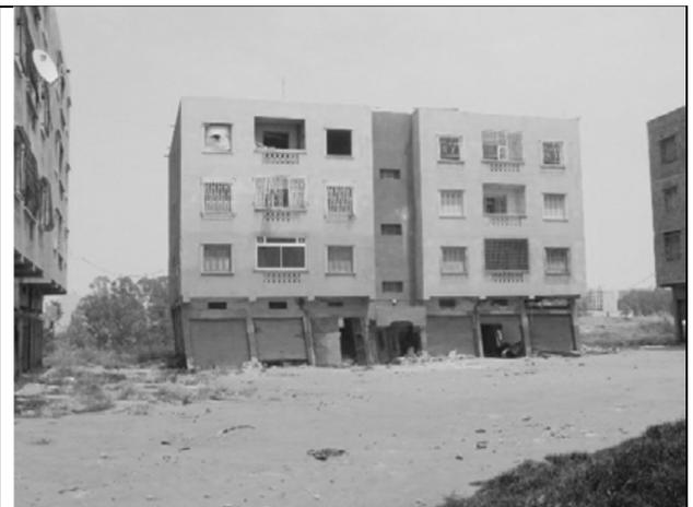
**Figure 2:** Bâtiments avec étage souple au RDC.
