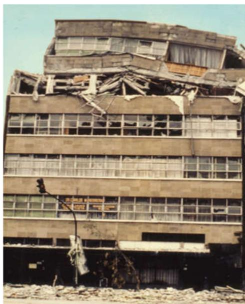
**Figure 1.16:** Effondrement de la partie supérieure du bâtiment (Mexico 1985)
