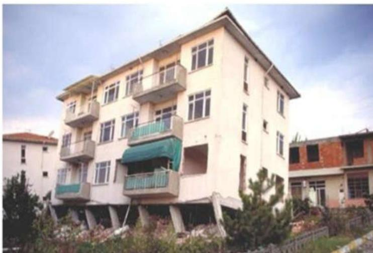
**Figure 1.10:** Effondrement sous l'effet d'un rez-de-chaussée " souple" (Bachmann, 2002)
