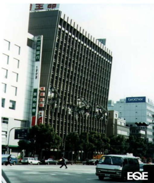
**Figure 1.17:** effondrement d'un immeuble avec bureaux. (Kobe en 1995)
