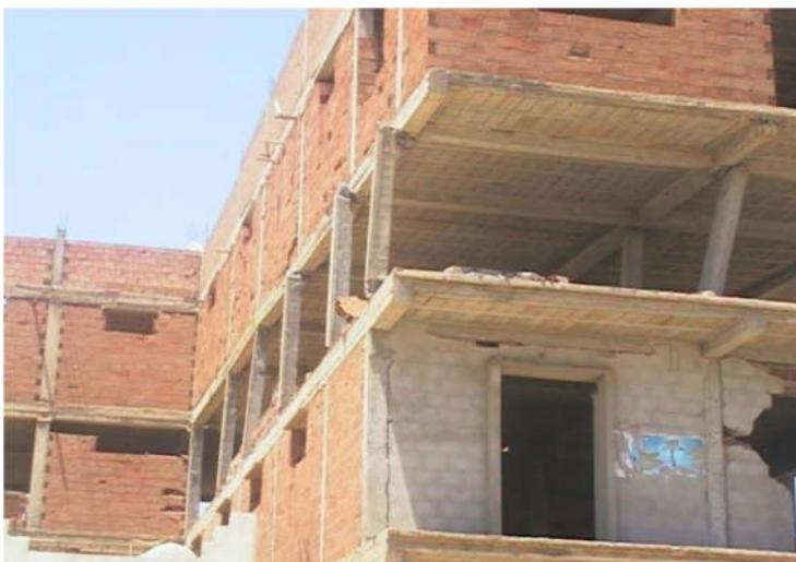
**Figure 1.12:** Cisaillement des poteaux d'une construction à Bordj el bahri. Séisme de 2003, Boumerdes, Algérie (Seghir, 2007)
