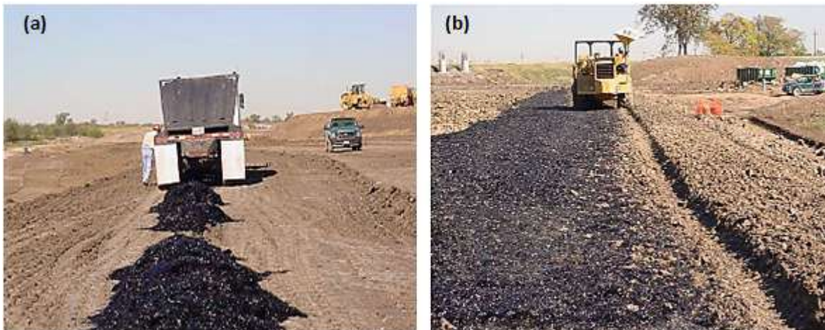
Figure 1.10- (a). Mise en place de fibres avec le sol, (b). répartition et compactage des fibres sur le terrain Projet PGBT situé dans la région de Dallas, Texas. (Gregory, 2006)
