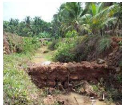
b) barrière en enrochement
