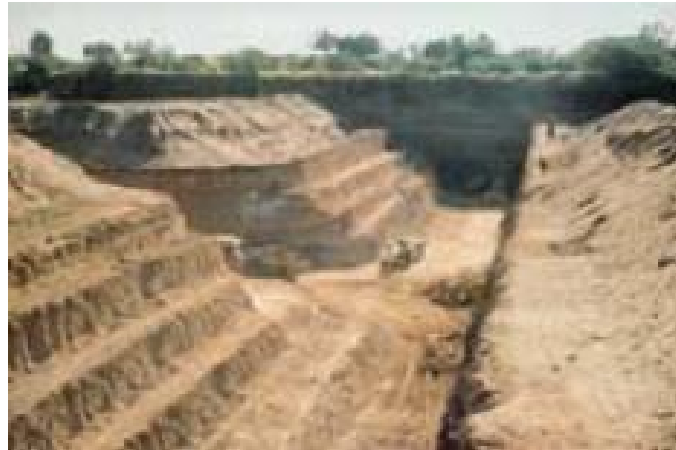
Figure 2.19: Réalisation d'un barrage d'inferoflux [IGRAC].
