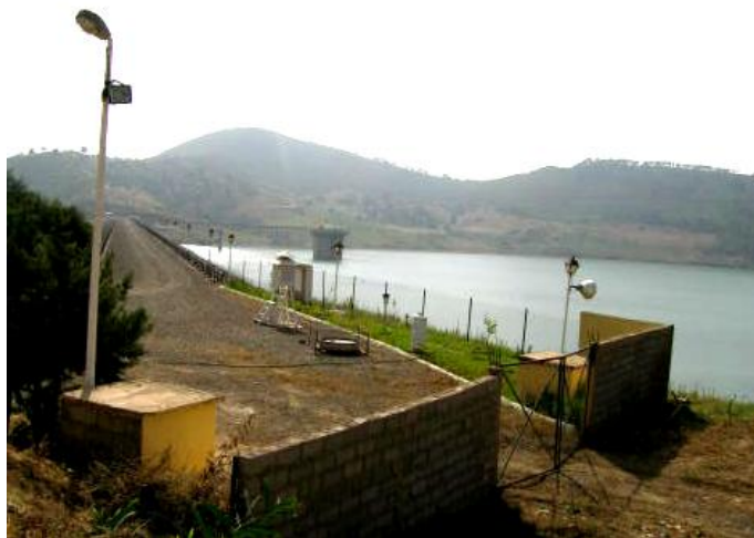
Figure 8.10: Vue sur la digue et le lac du barrage de Boukourdane.
