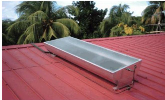
**Figure III.8 :** Chauffe-eau « autostockeur », Web03.
