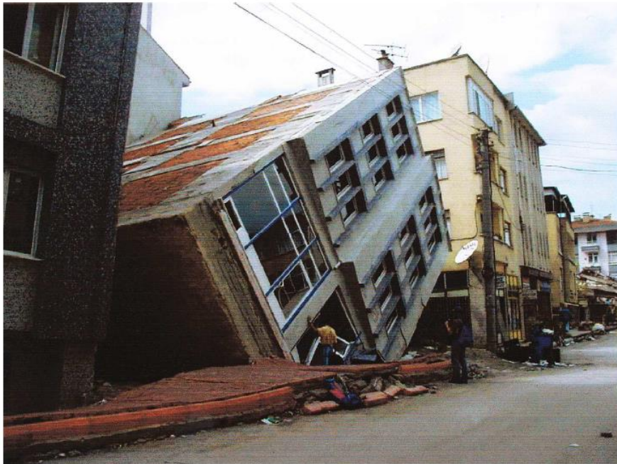
Figure 6.3 Basculement (de 55°) d'un immeuble à Adapazari (Celebi et al., 2000).
