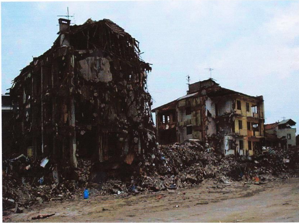
Figure 6.1 Effets de sites dans la zone de remplissage alluvial d'Adapazari (Rapport AFPS 1999).
