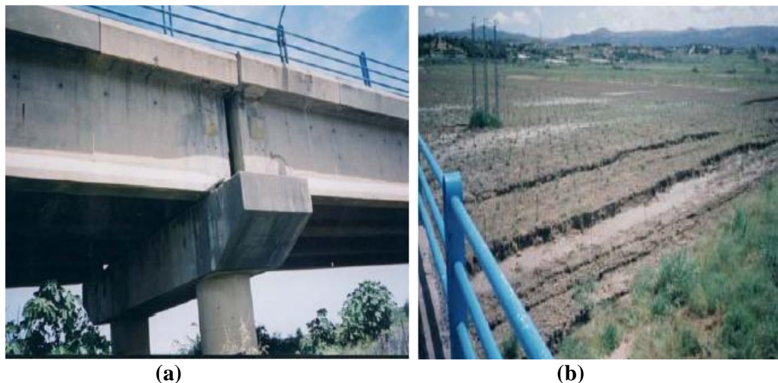
Figure 1.3 (a) Déplacement latéral et longitudinal du pont, (b) Déplacements latéraux du terrain.
