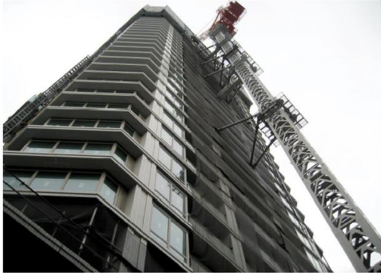
Figure 3.23 – La tour Nabeaura à Yokohama, au Japon, utilise des poutres de CCHD préfabriquées pour la résistance au séisme (Maruta et al., 2005).
