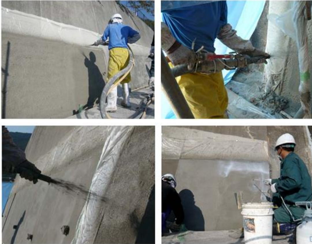
Figure 3.20 – Application du CCHD sur un mur de soutènement ( Li 2009 ).
