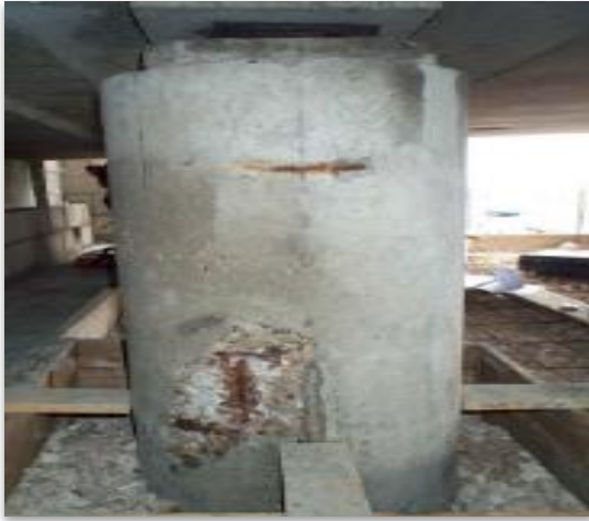
(a) Éclatement de béton dû à la corrosion
