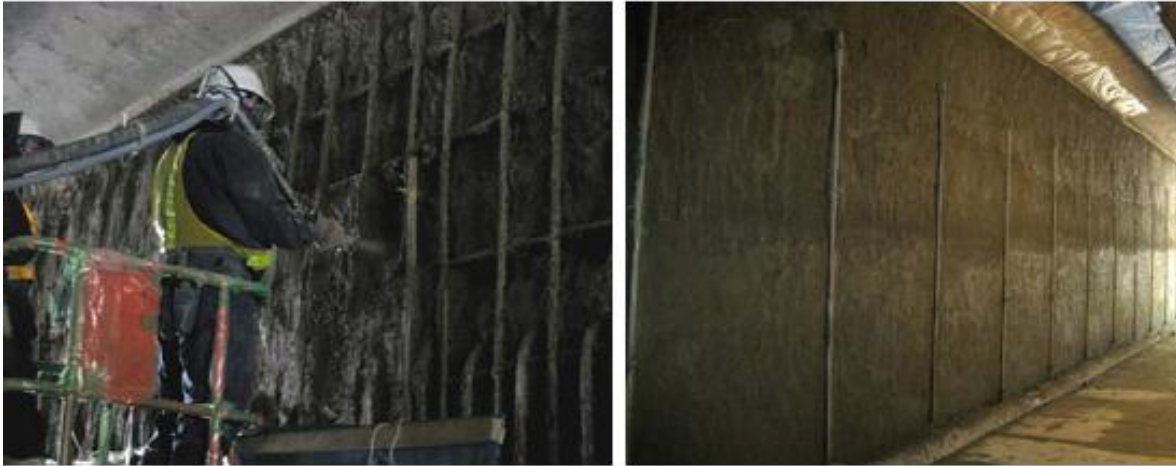
Figure 3.21 – Réparation du tunnel par le CCHD (Qian, 2009)..
