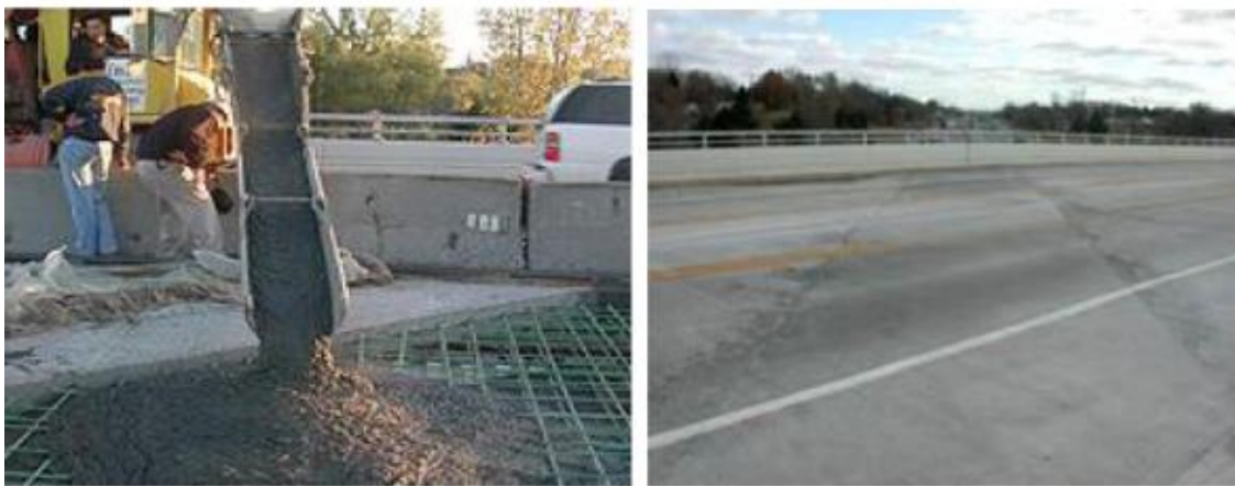
Figure 3.22 Tablier en CCHD, Grove, Rue, pont de Grove, Michigan (Qian, 2009).
