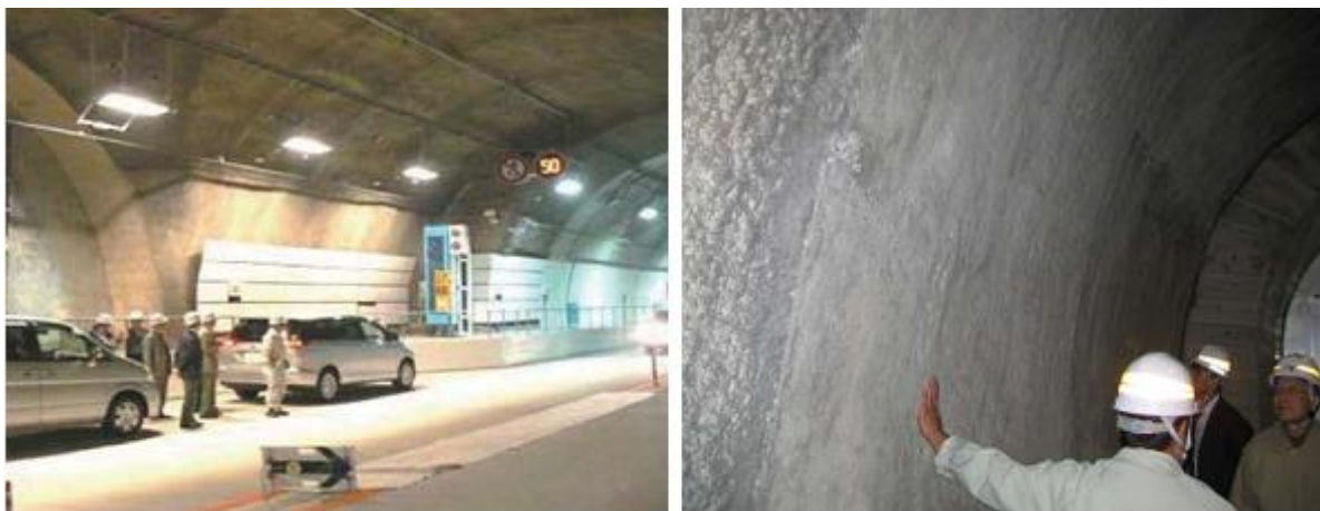
Figure 3.19 – Projection du CCHD comme un revêtement dans le tunnel Hida au Japon (Li 2009).
