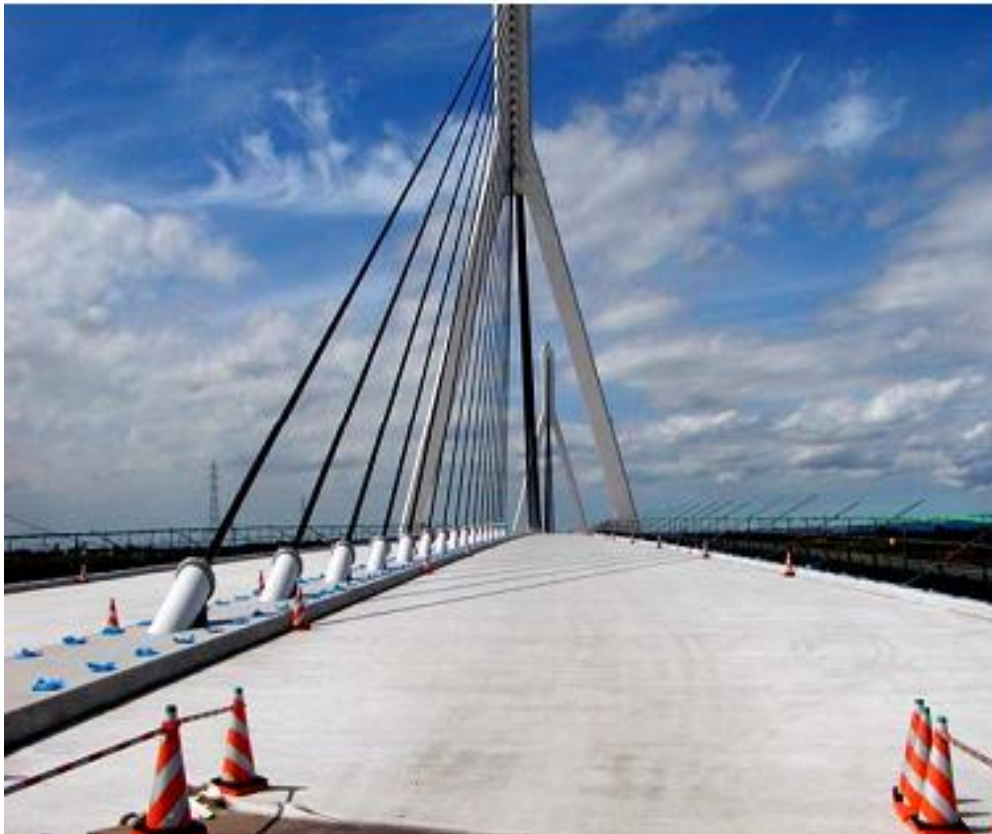
Figure 3.17 – Un tablier en CCHD du pont de Mihara au Japon en Avril 2005 (Li 2009).
