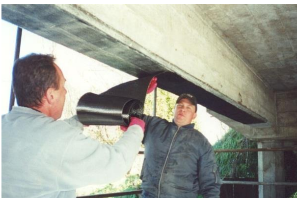
(f)- Renforcement par matériau composite
