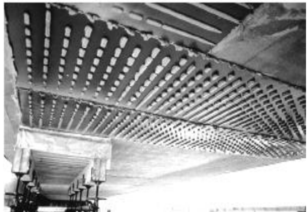
(d)- Renforcement par collage des plaques métalliques.
