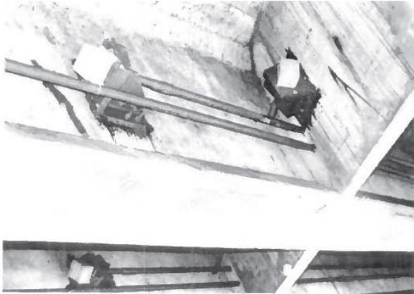
(a)- Précontrainte additionnelle extérieur.
