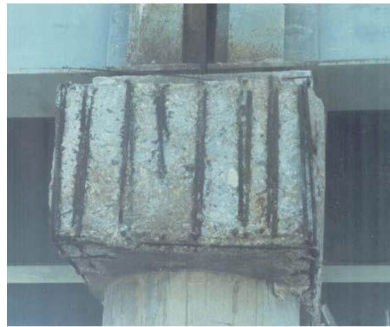
(a) Éclatement de béton dû à la corrosion
