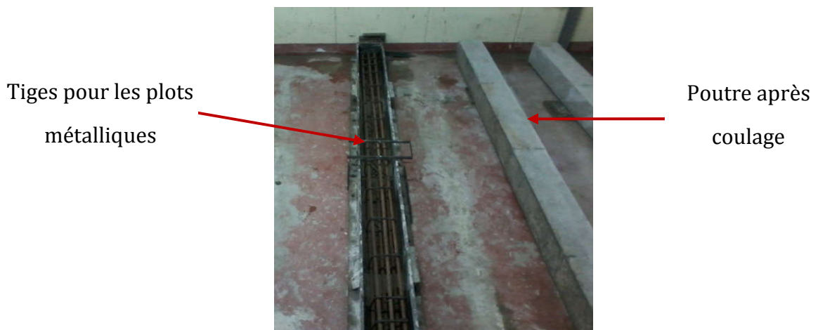
Figure 7-4: Poutre avant et après le coulage.
