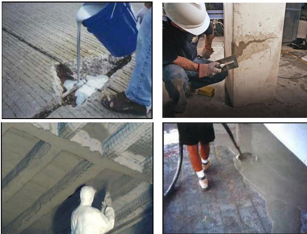
Figure 2.1 – Quelques applications de mortier autoplaçant de réparation.
