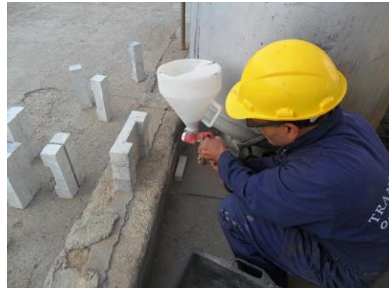
Figure 4.18 – Traitement de surface des parties évidées des substrats par sablage.
