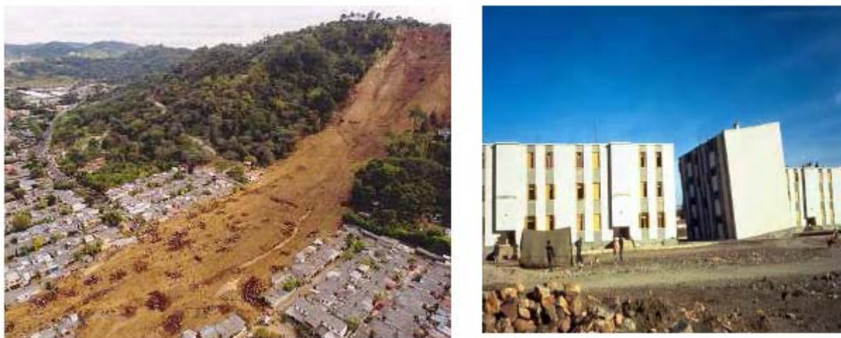
Figure 1. 23: Rupture diffuse, Glissement de terrain en rupture diffuse, Santa Tecla Salvador, 2001 ; Basculement de Bâtiment à El Asnam, Algérie en 1980.
