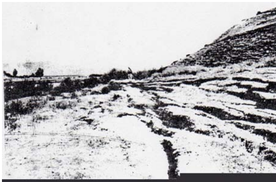
(a) Glissement de terrain le long des berges d'oued Chlef
