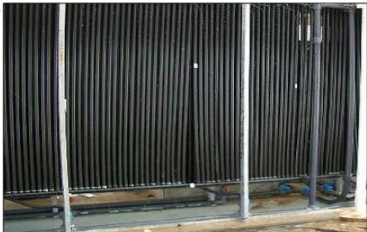
Figure III.4: Schéma du condenseur de la serre [III. 7].
