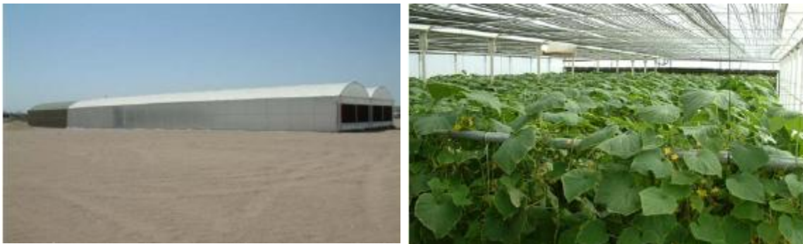
Figure III.1 : Production de concombres à Mascate avec succès tout au long des mois d'été les plus chauds. Serre chaude (mai 2005) [III.1].
