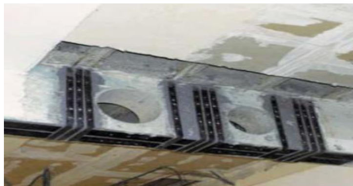
Figure 2.15. Différentes méthodes de renforcement par le collage de plaques en composites [47]
