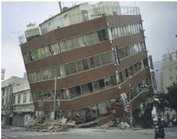
(a). Effondrement de l'étage inférieur (Kobe, 1995) (b). Rupture des têtes de poteaux (séisme de Boumerdes 2003)
