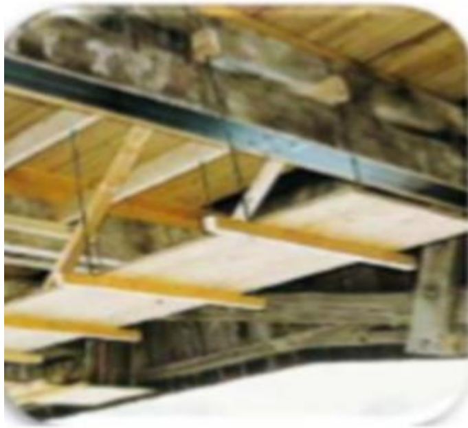
Figure 2.23. Mise en place des lamelles sur une structure bois
