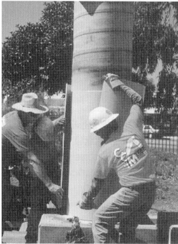
Figure 2.18. Chemisage par coquille préfabriquée en «FRP» (Monti 2003) [51].
