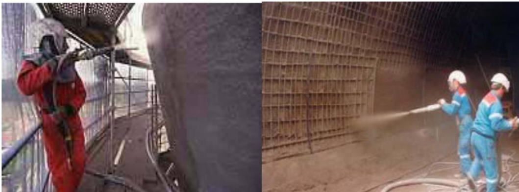
Figure 2.2. Renforcement au moyen de béton projeté
