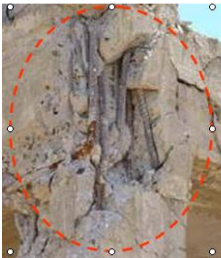
(c). Absence de cadres dans le nœud (d). Écrasement du béton (séisme de Boumerdes 2003)
