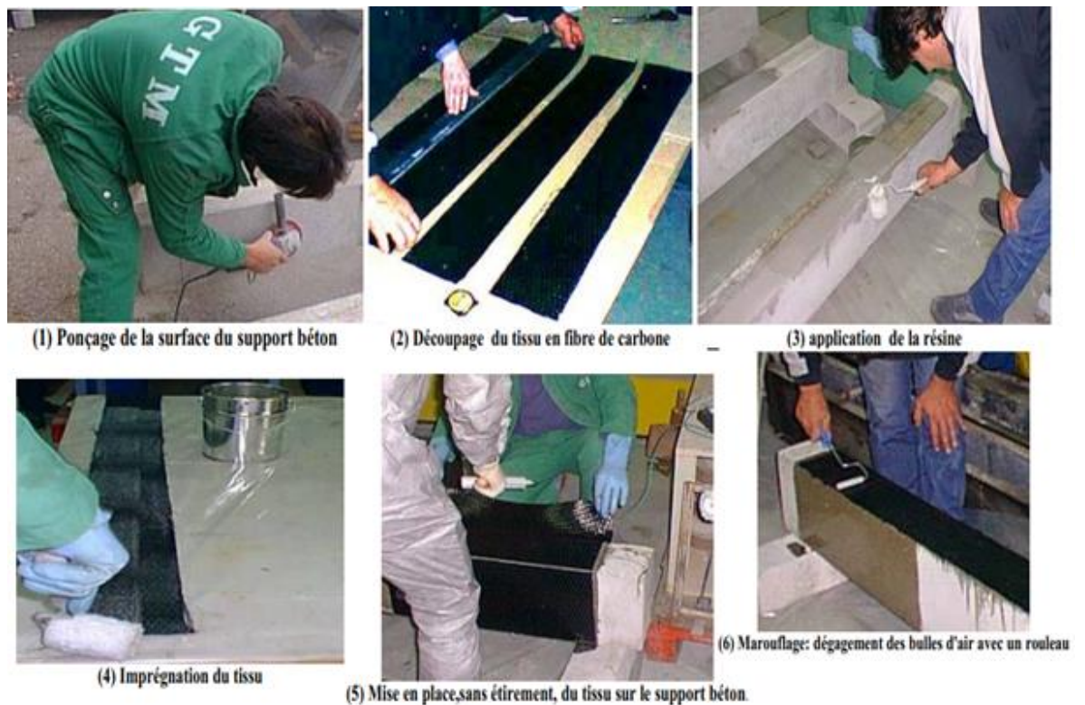
Figure 2.13. Procédé de mise en œuvre des matériaux composites [45].
