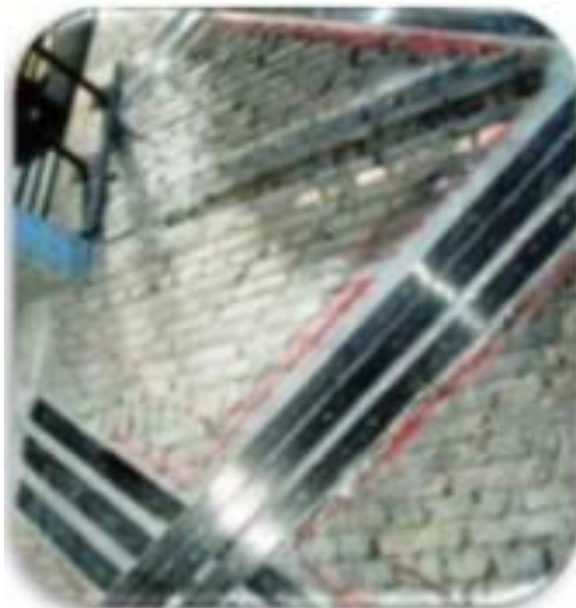
Figure 2.22. Mise en place des lamelles sur un mur en briques
