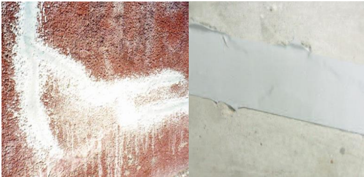
(a) Calfeutrement de fissures à l'aide d'un base de liants hydrauliques
