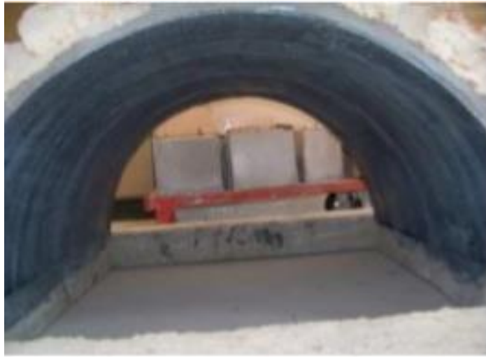
Figure 2.25. Mise en place des tissus de carbone sur des voûtes [52]
