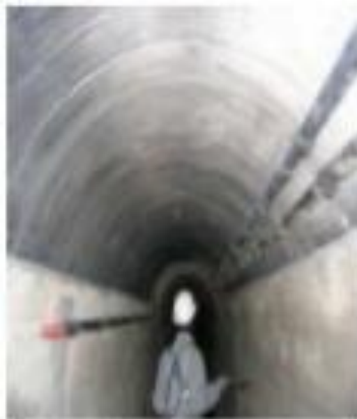
Figure 2.26. Mise en place des lamelles sur des ovoïdes en béton armé Val-de-Marne (94)
