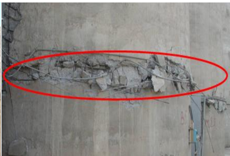
(c). Absence de cadres dans le nœud (d). Écrasement du béton (séisme de Boumerdes 2003)
