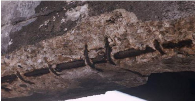
(a) Pont à poutre
