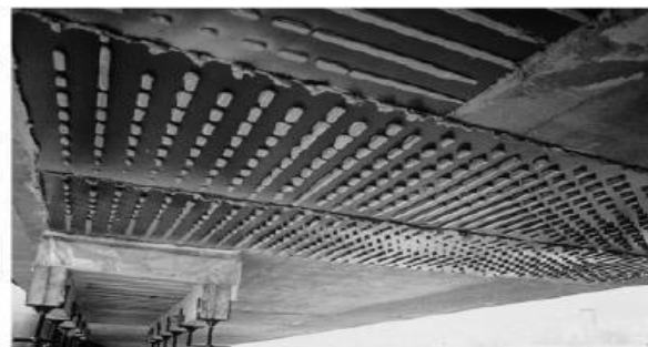
(b) Renforcement du viaduc par tôles collées perforées
