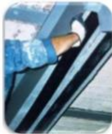
Figure 2.19. Mise en place des lamelles sur une poutre
