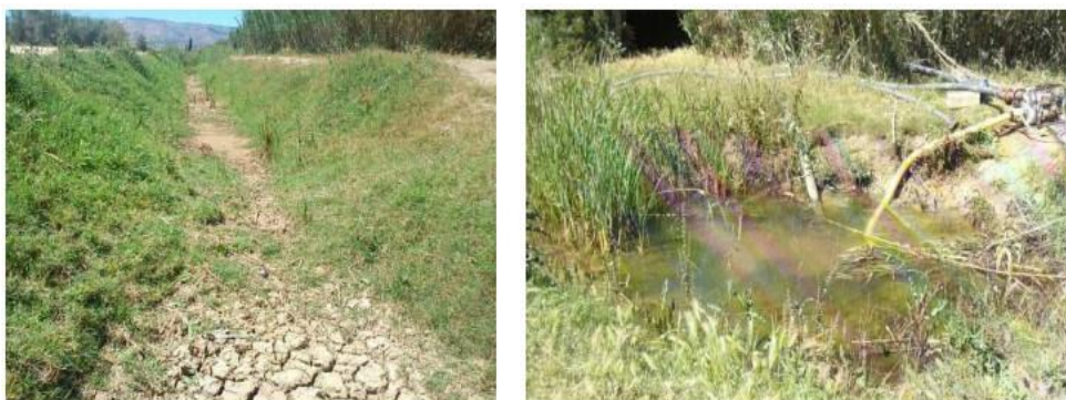
Photo n°3 : Etat actuel du drainage dans le Bas-Chéiff (Bradai, 2017).
