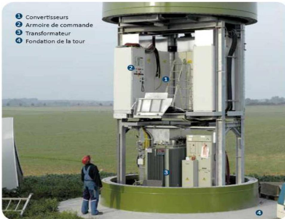
Figure I-17 : La tour éolienne et ses composants électroniques à l'intérieur.
