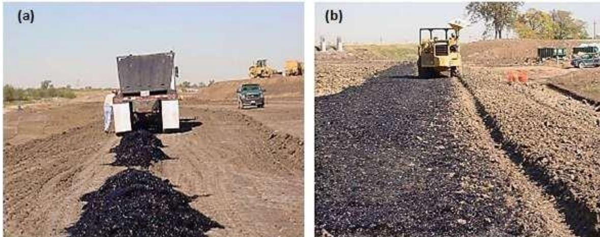
**Figure 2. 2 :** (a). Mise en place de fibres avec le sol, (b). Répartition et compactage des fibres sur le terrain Projet PGBT situé dans la région de Dallas, Texas. (Gregory 2006).
