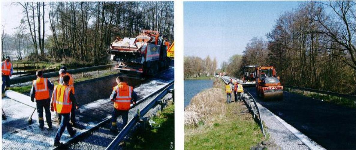
**Figure 2. 16 :** Mise en œuvre de Colgrill a. RD 624 (11) b. RD 438 à Saint-Simon (02)
