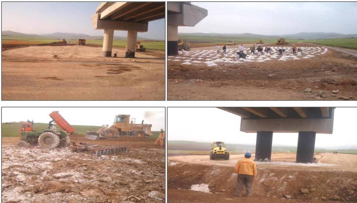
**Figure 1. 16:** (a). Site du traitement, (b) Epannage de la chaux, (c) Malaxage, (d) Compactage du sol traité.
