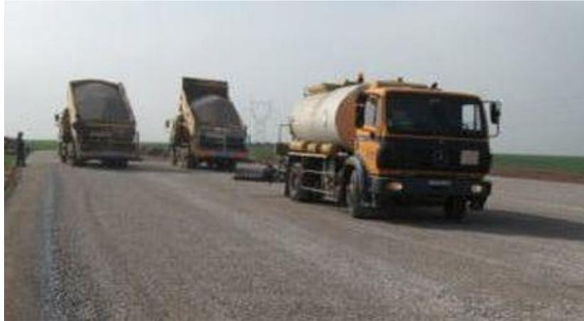
**Figure 1. 17:** Protection de surface du sol traité par ciment.
