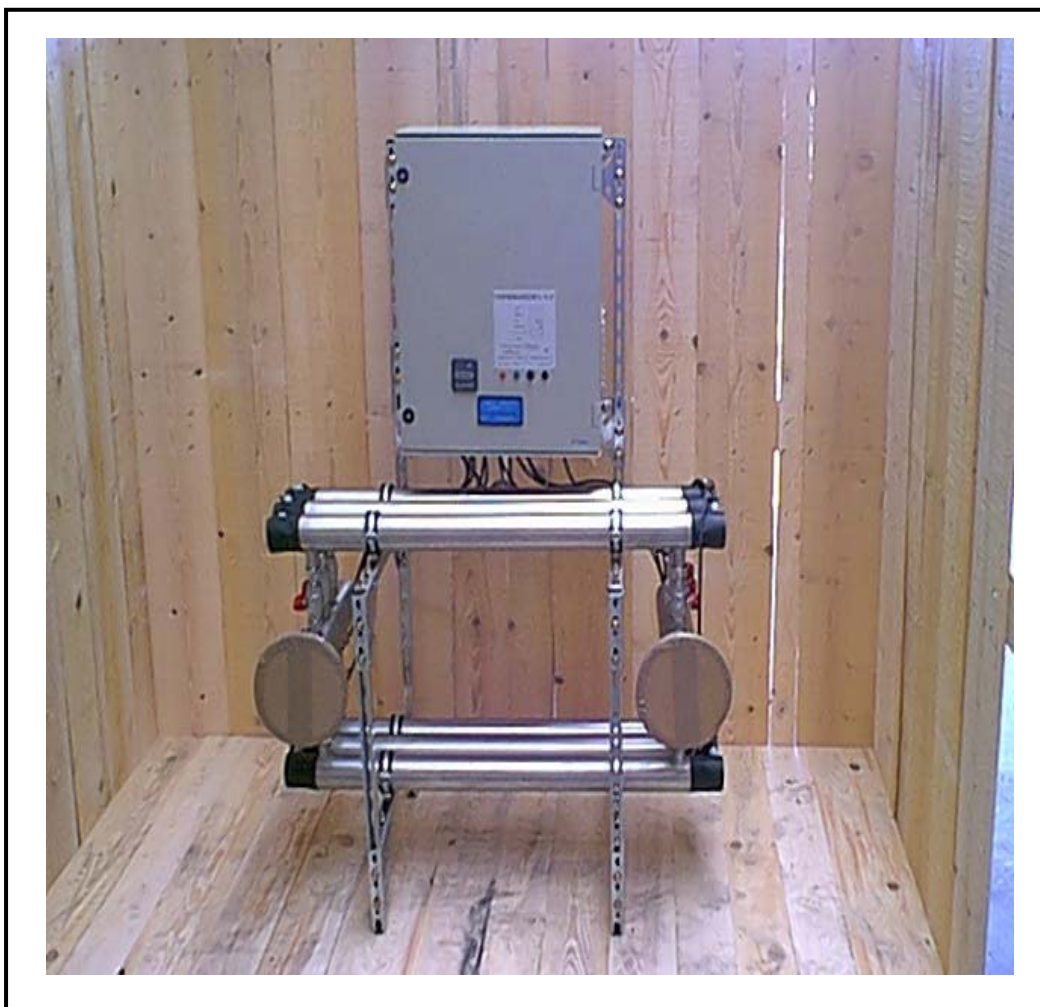
Fig.1.7: Dispositif réel de traitement des eaux par rayonnement U.V. [90]
