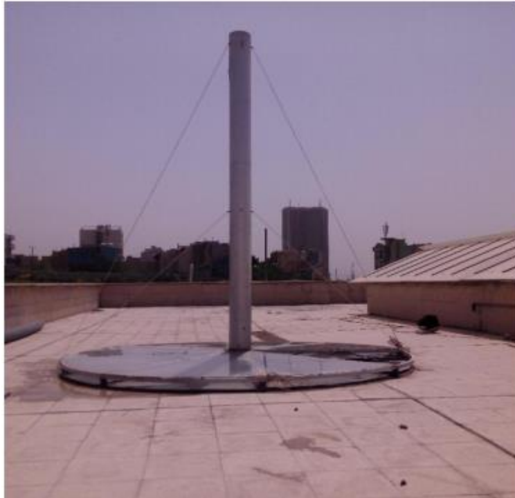
Fig. II.14. Expérimental de cheminée solaire à Téhéran
