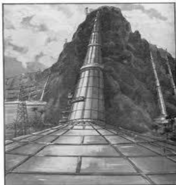
Fig.II.4. Cheminées solaires dans le désert marocain [46].
