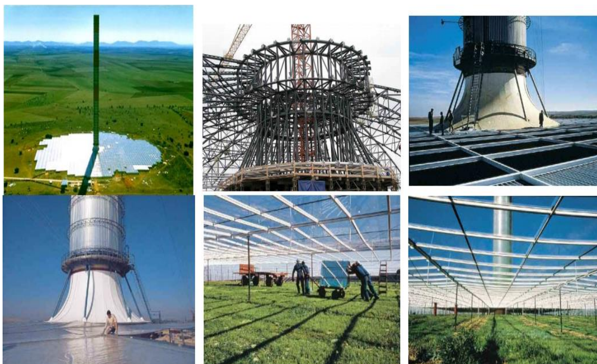
Fig. II.8. Photos de prototype de cheminée solaire installée à Manzanares (Espagne) [7-46]
