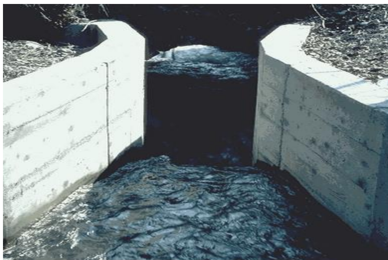
Figure I. 6: Seuils-jaugeurs (venturi).
