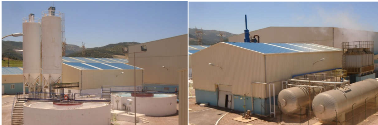
Figure III.4. Prétraitement physique, -traitement: (a) dosage de lait de chaux, (b) production stockage et dosage de CO 2 . [41]
