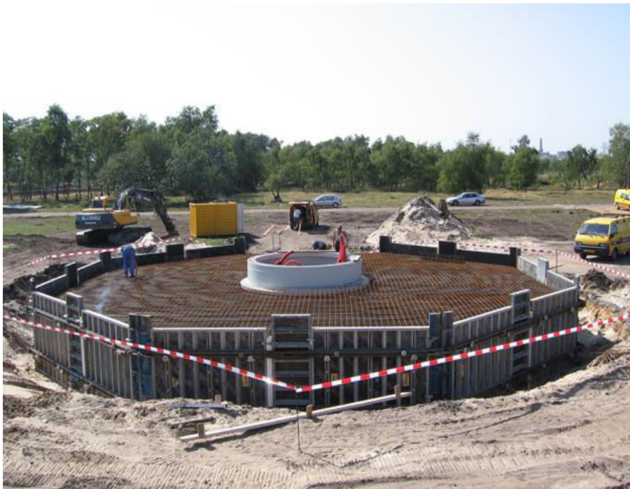
Figure 2.7: Fondation de l'éolienne
