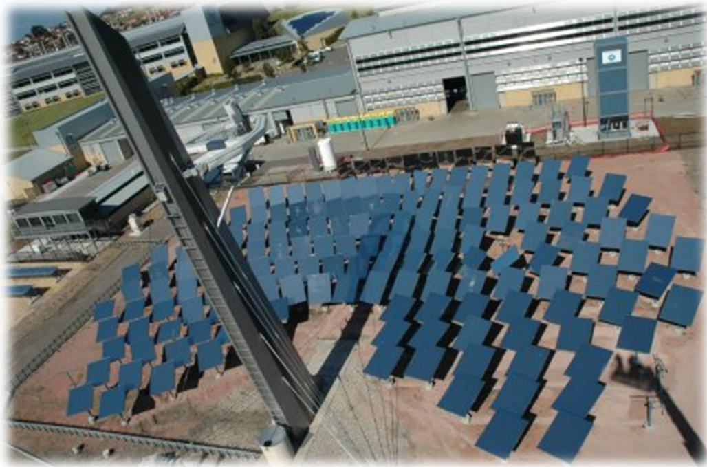
Figure 1.5 : Exemple de la solaire thermique haute température
