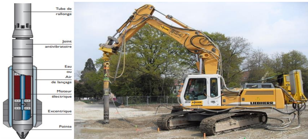
Fig. 1.27 — Outils utilisés à la méthode de vibrocompactage.
