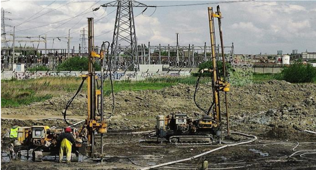
Fig. 1.32 — Colonnes Ballastées Injectées, Centre de Valorisation Organique (Sequedin).
