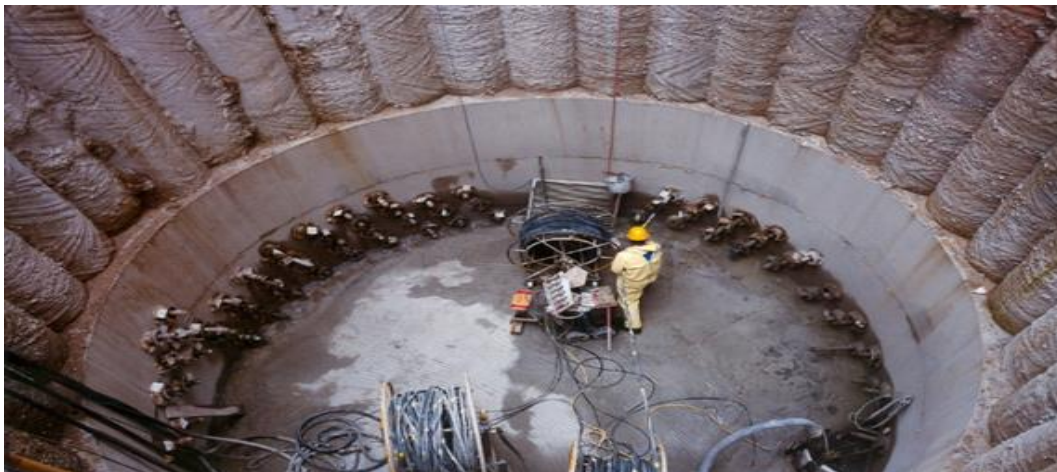
Fig. 1.51 — Injections de compensation - City Tunnel - Leipzig (Allemagne) – 2007
