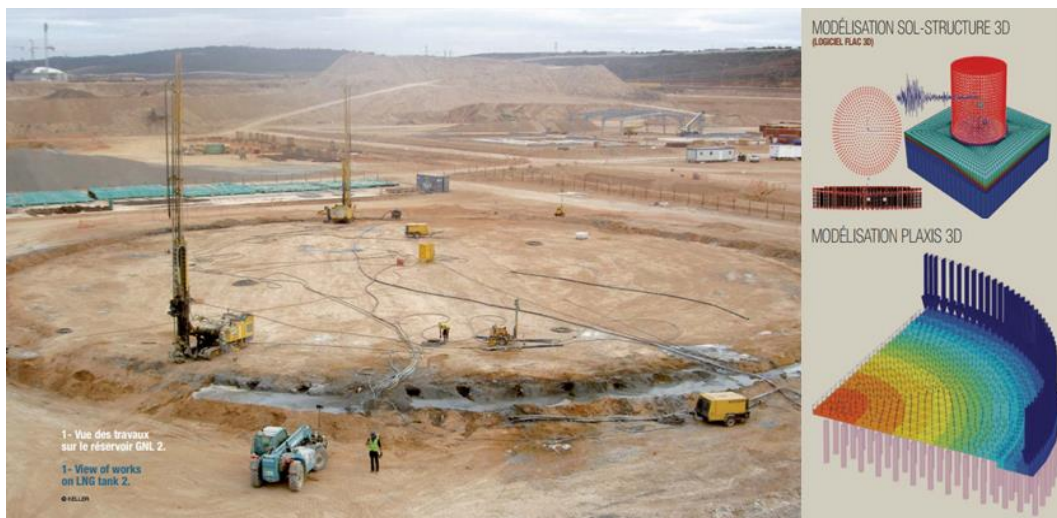
Fig. 1.49 — Renforcement du sol sous réservoirs GNL à ARZEW, en ALGÉRIE par la méthode Jet Grouting.
