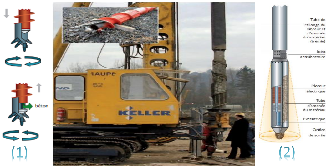
Fig. 1.38 — Outils utilisés dans la méthode de Colonne à Module Mixte. (1) Pour la partie inférieure en béton (2) Pour la partie supérieure en gravier.
