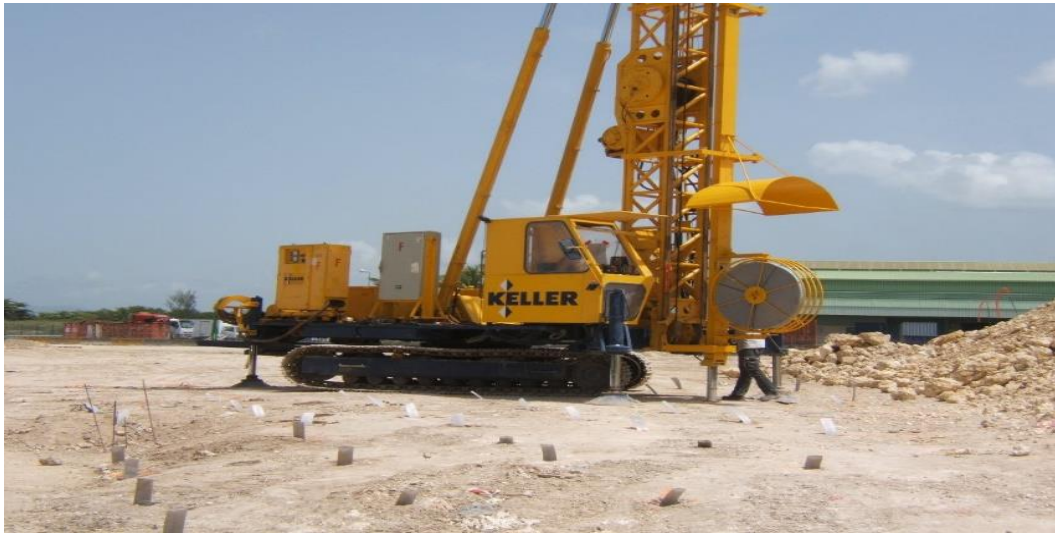
Fig. 1.21 — Drains verticaux - Entrepôt frigorifique au Port Autonome de Guadeloupe – 2007
