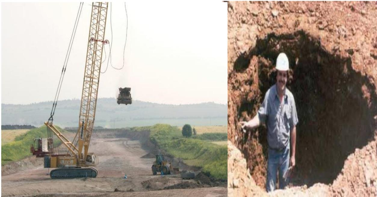
**Figure 1.9** — Densification d'un terrain par compactage dynamique.
