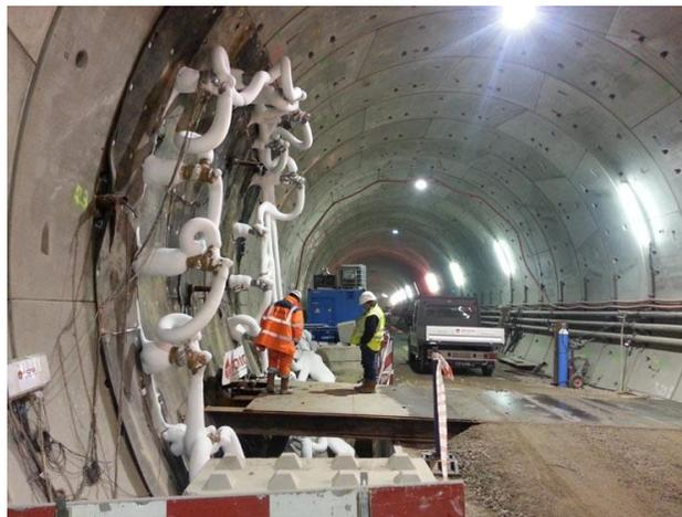
**Figure 1.14** — Stabilisation provisoire des parois d'un fond par la technique de congélation.
