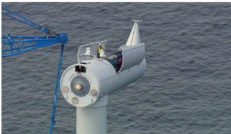
Figure I. 12 : Vue aérienne de la nacelle pendant l'assemblage d'une turbine éolienne.
