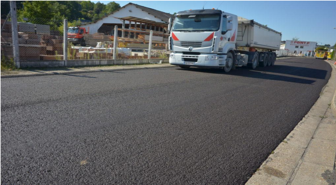
Figure 2. 2- Réalisation d'une couche de surface par un enrobé coulé à froid (source IBEF*Canada). (* International bitumenemulsionfederation).
