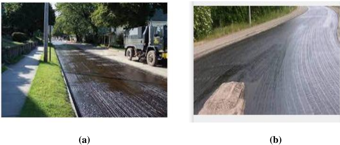
Figure 1. 3- Mise en service : a) couche d'accrochage b) couche de liaison.
