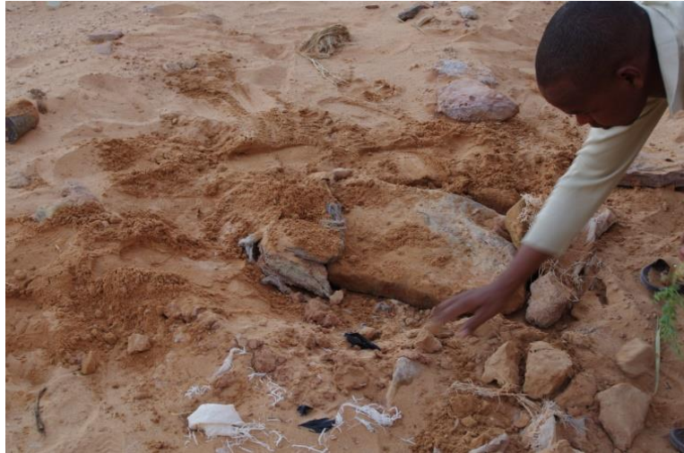
Figure. 4.24. Foggara de Tafza : Opération de recouvrement d'une kasria par des roches plates (2016)
