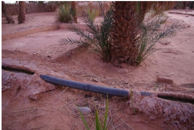
Figure.4.22. Foggara de Tafza : Remplacement des seguias par des conduites en PVC (2016)
