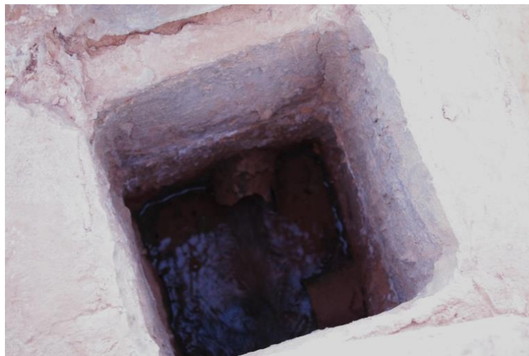
b) Regard d'évacuation d'eau
