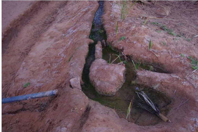
Figure .4.15. Une kasria tertiaire du réseau de la foggara de Tafza (2016)
