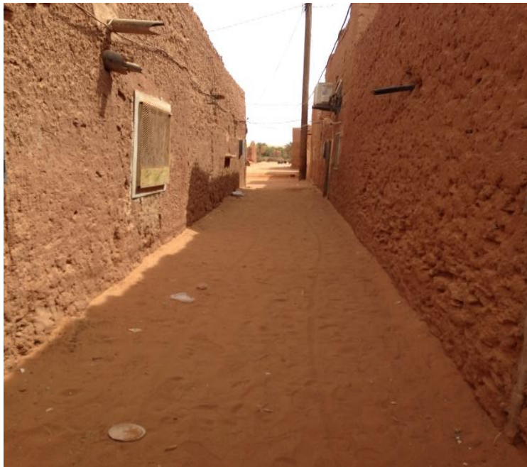
Figure.3.18. La construction des maisons à In Ghar (2016)
