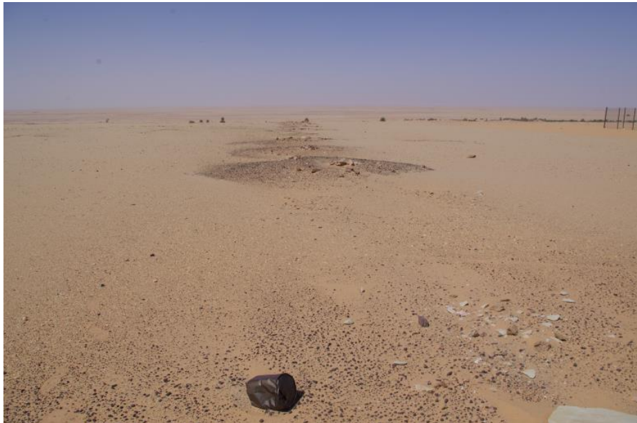
Figure. 3.3. Alignement des puits de la foggara avec un espacement de 12 m (2016)
