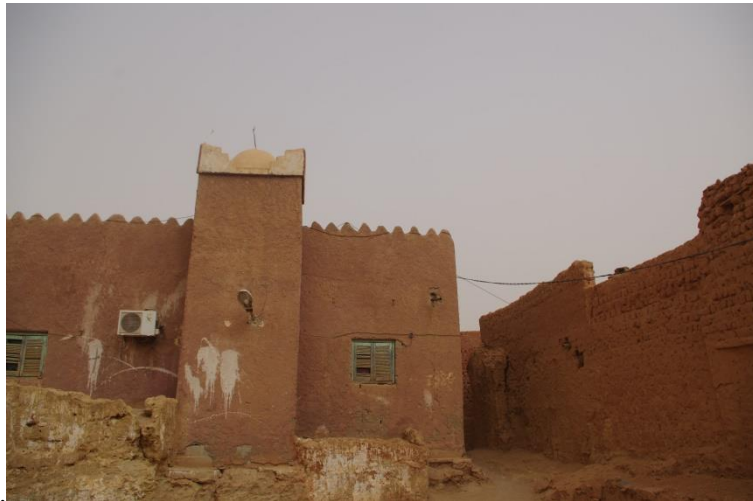
Figure.3.16. La mosquée du ksar à In Ghar (2016)
