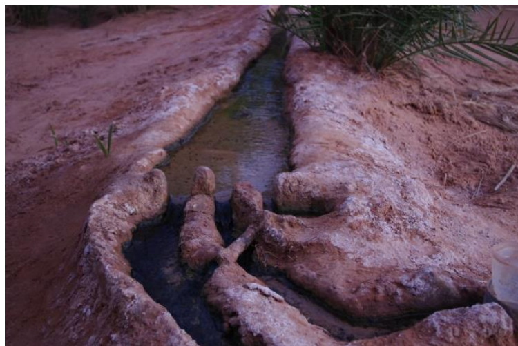
Figure.4.14. Une kasria secondaire du réseau de la foggara de Tafza (2016)
