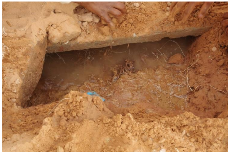
Figure. 4.25. Foggara Tafza : Opération de nettoyage d'une kasria des racines de la plante Taghinemt (2016)
