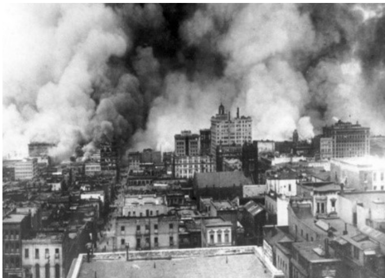
Figure 1-2. Séisme de San Francisco 1906 [10]
