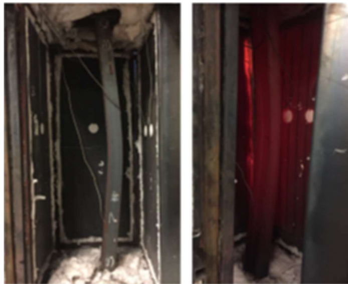
Figure 1-7. Flambement du poteau causé par la simulation du séisme [58]
