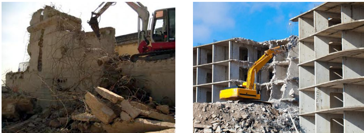
Figure 1.1. Déchets de démolition
