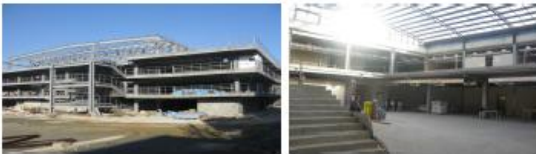
Food Center – Centre commercial Bab Ezzouar - Parking à étages
