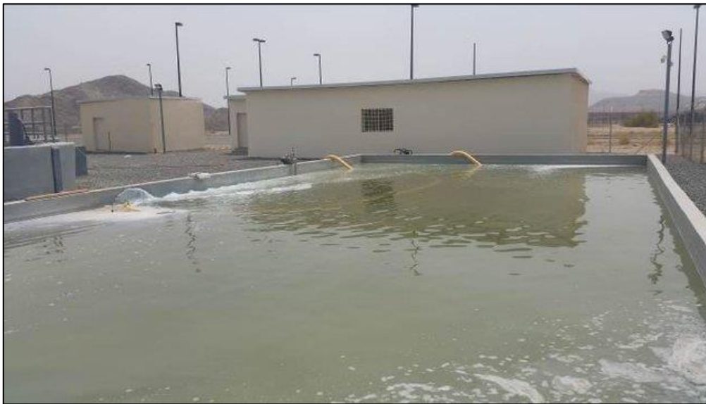
Figure I.5: Bassin d'évaporation (Rajhi et al. , 2018).
