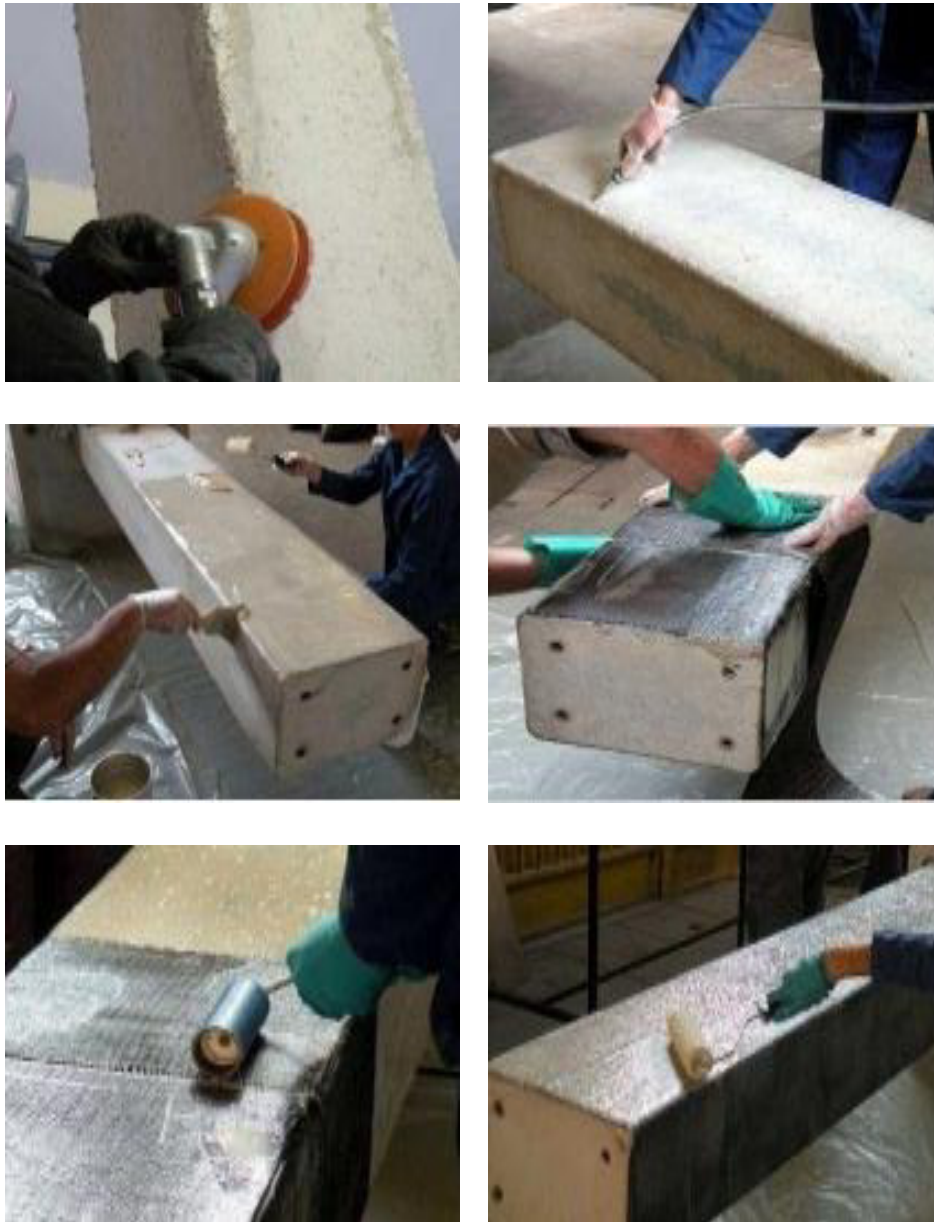
Figure I.22 : Mise en place du composites FRP par stratification directe (Chakra 2016).
