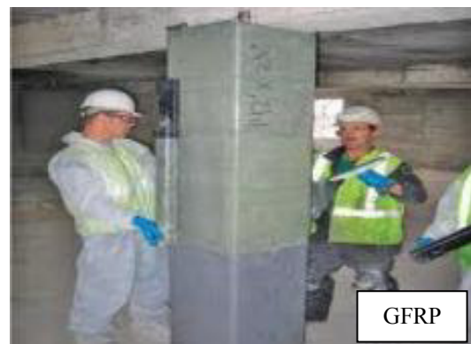
Figure I.12 : Confinement de colonnes et poteaux à l'aide de tissu en FRP (Chowdhury et Islam 2014).
