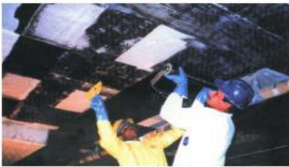
Figure I.11 : Renforcement en flexion d'une poutre en béton armé à l'aide des feuilles en polymère renforcé de fibres de carbone CFRP (ACI 440.2R 2008).
