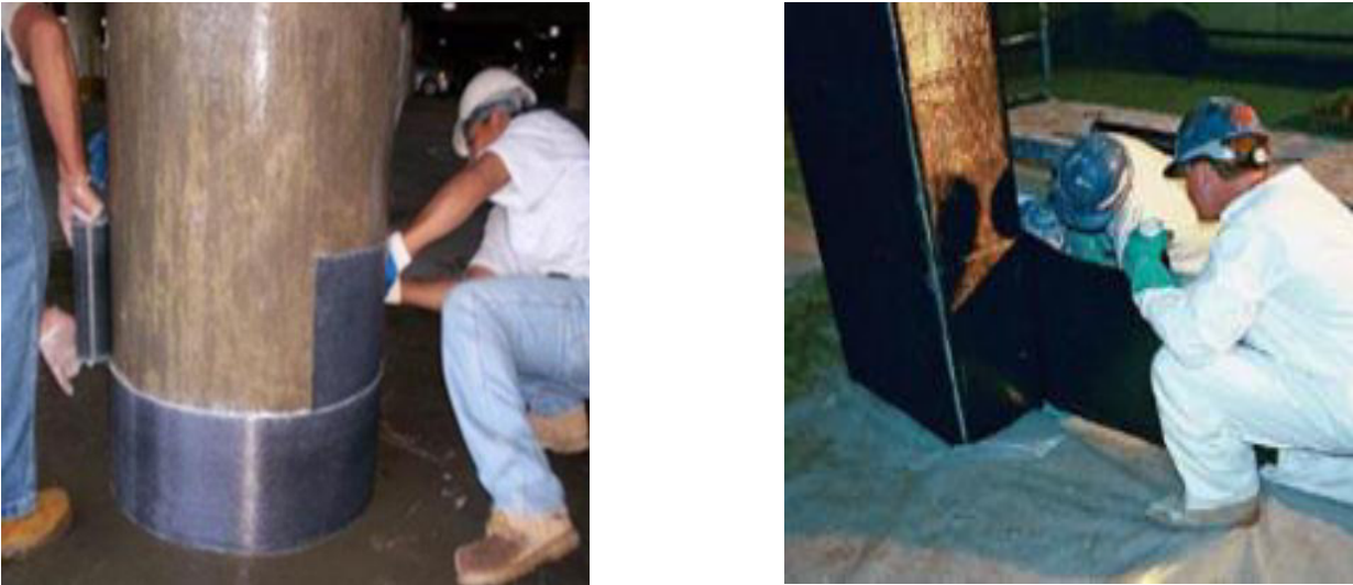
Figure I.20 : Stratification en contact des colonnes (Chakra 2016).
