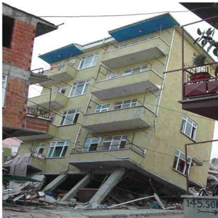
Figure I.1 : Effondrement d'un bâtiment à cause de l'étage souple (Golcuk, Turkey 1999).
