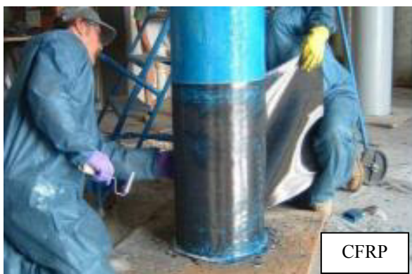
Figure I.12 : Confinement de colonnes et poteaux à l'aide de tissu en FRP (Chowdhury et Islam 2014).
