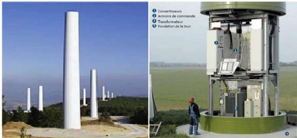
Figure I.12 : La tour éolienne et ses composants électroniques à l'intérieur.
