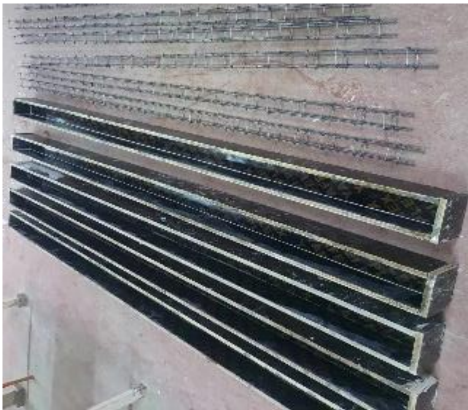
Figure 2. 20. Coffrage des poutres.
