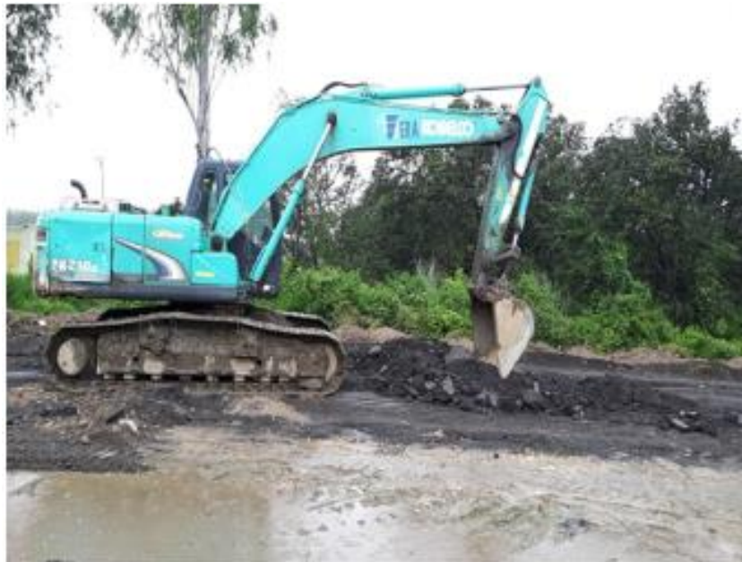
Figure 1. 8. Fraisage incontrôlé (scarification) par bulldozer.
