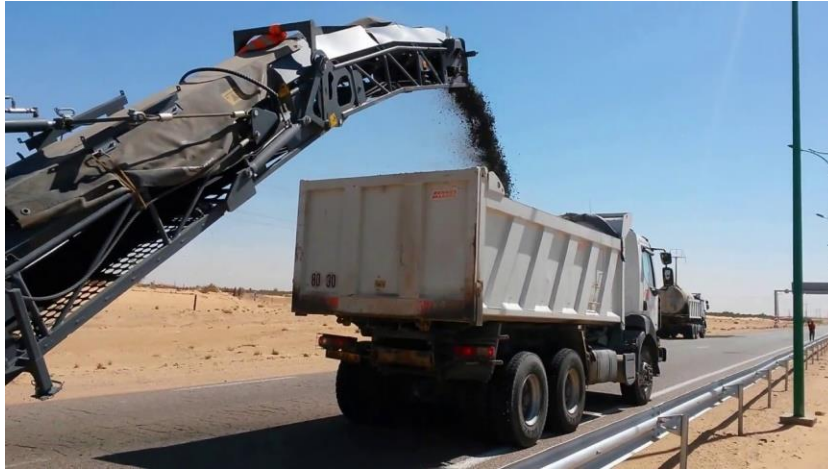
Figure 1. 7. Fraisage contrôlé par fraiseuse.
