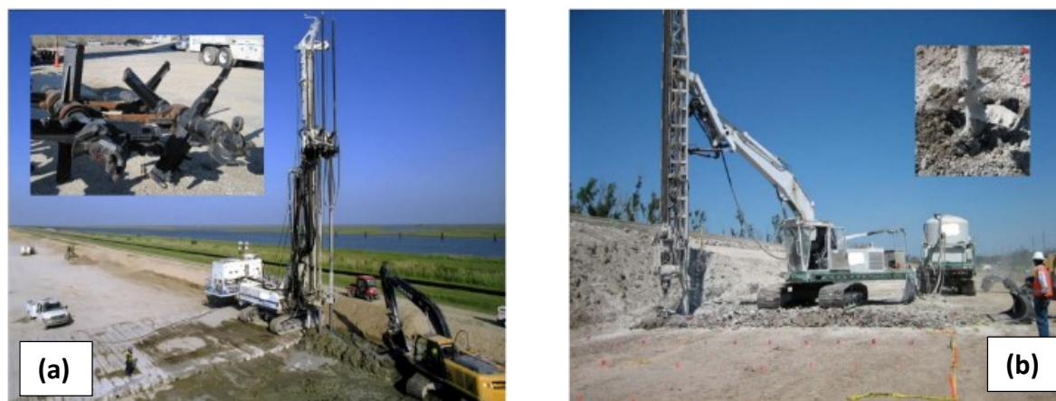
Figure 2. 6 : Mélange en profondeur ; a) la méthode humide ; b) la méthode sec (Schaefer et al., 2016b)
