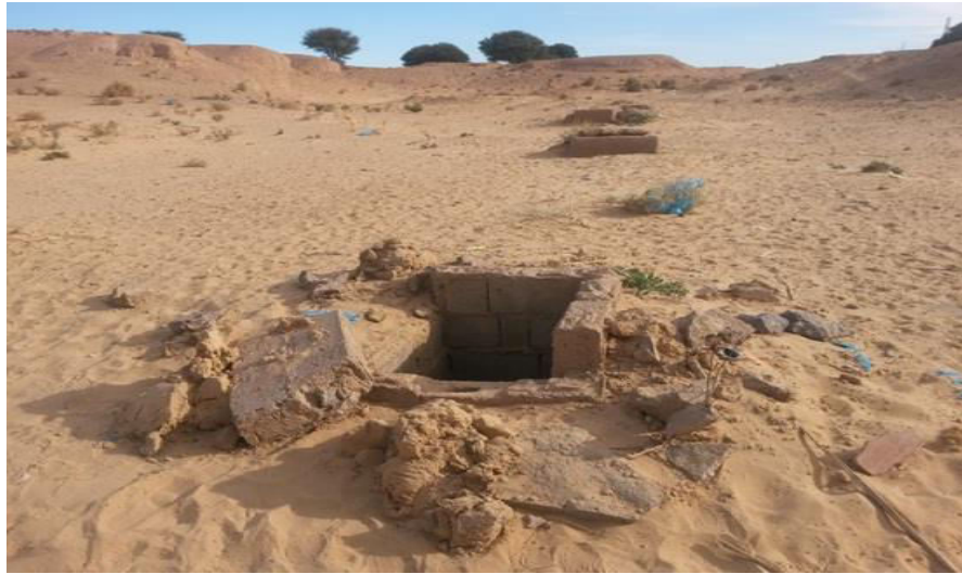
Figure D.5: Puits d'aération d'une foggara à l'oasis de Taghit.
