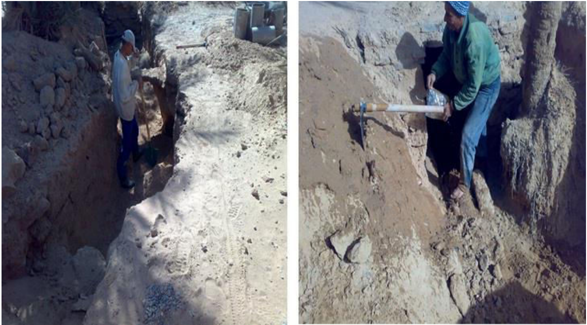
Photo B.4: Les travaux de réhabilitation des foggaras de Béni Ounif (2008).
