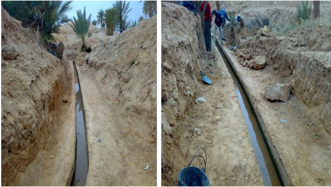
Photo B.5 : Réhabilitation des seguias de l'oasis de Béni Ounif (2008).
