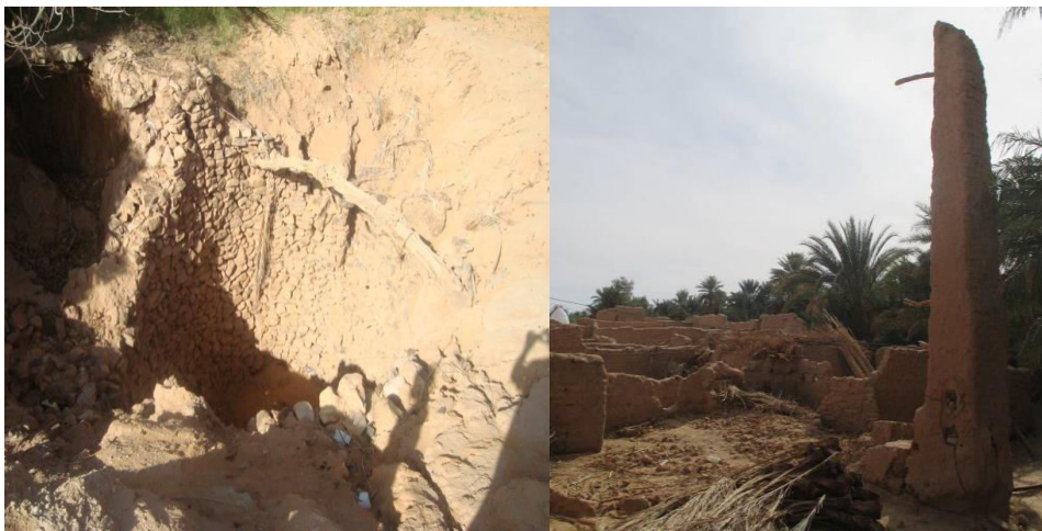
photo III.3 Khottara effondrée lors de la crue de 2008 (Remini B, 2014).
