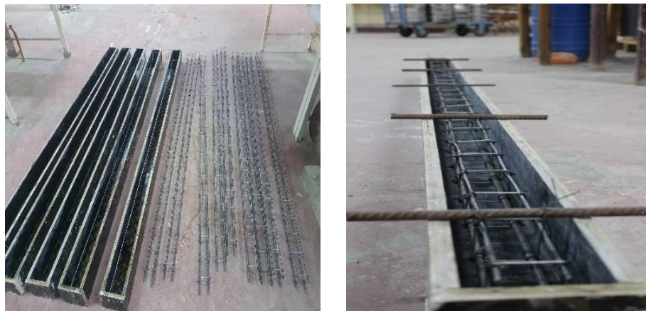
(1) Coffrage et ferrailage.
