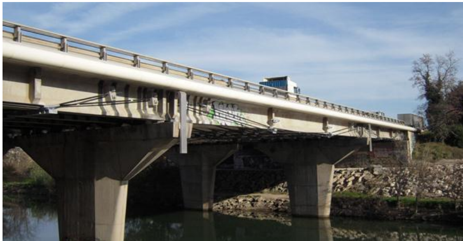
Figure I.11: Application de la précontrainte externe pour réparer les ponts à poutres
