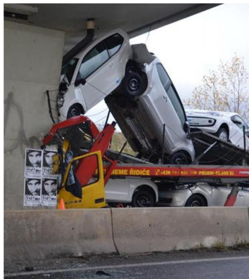
Figure I.4: Choc à cause des poids lourds hors gabarit contre l'intrados du pont [50]
