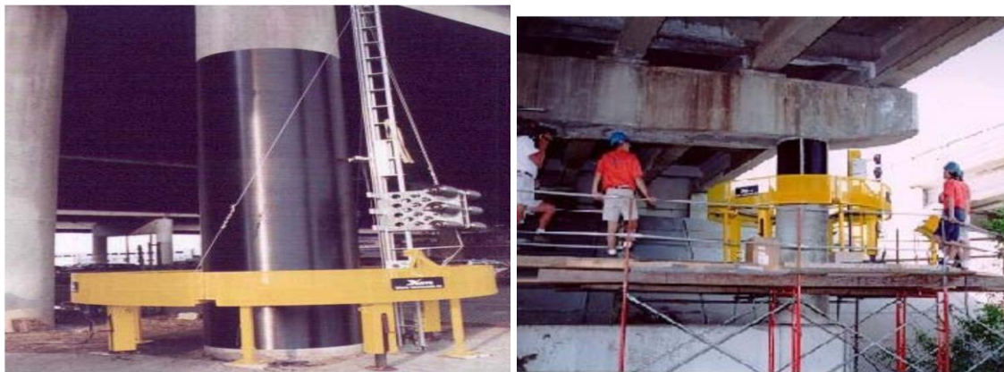
Figure I.16: Application de renfort sur la face d'un poteau [100]
