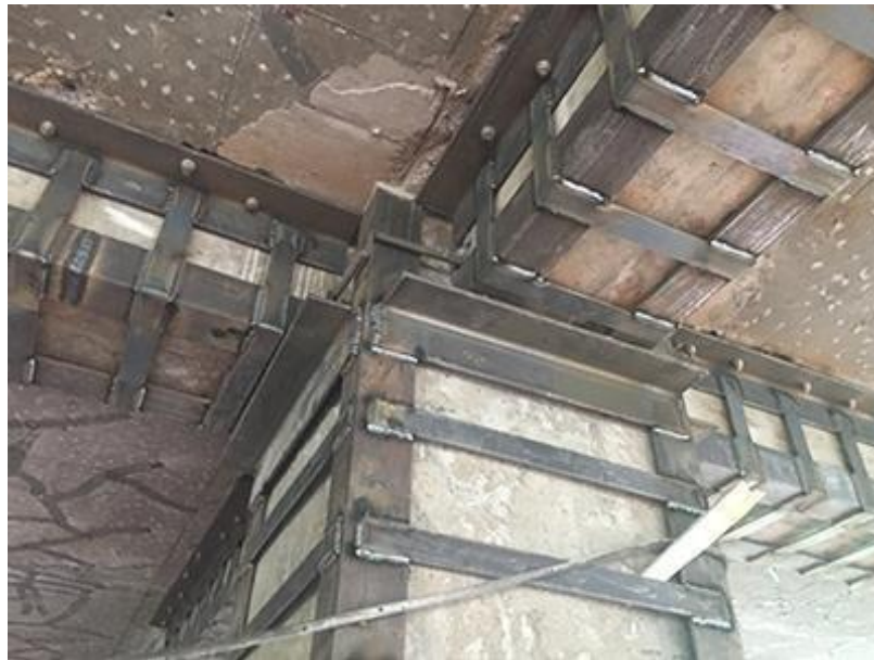
Figure I.10: Chemisage par acier [63]
