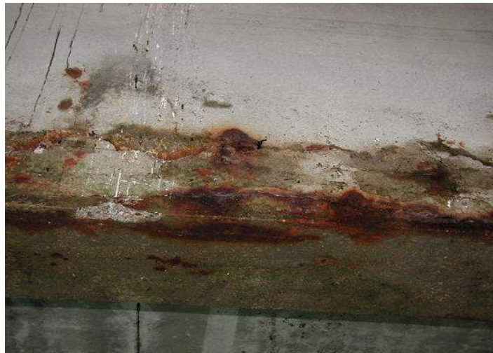
Figure I.7: Poutre exposée aux chlorures en bord de mer
