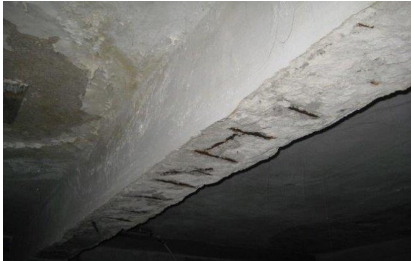
Figure I.8: Dégradation des éléments d'un ouvrage par carbonatation [62]
