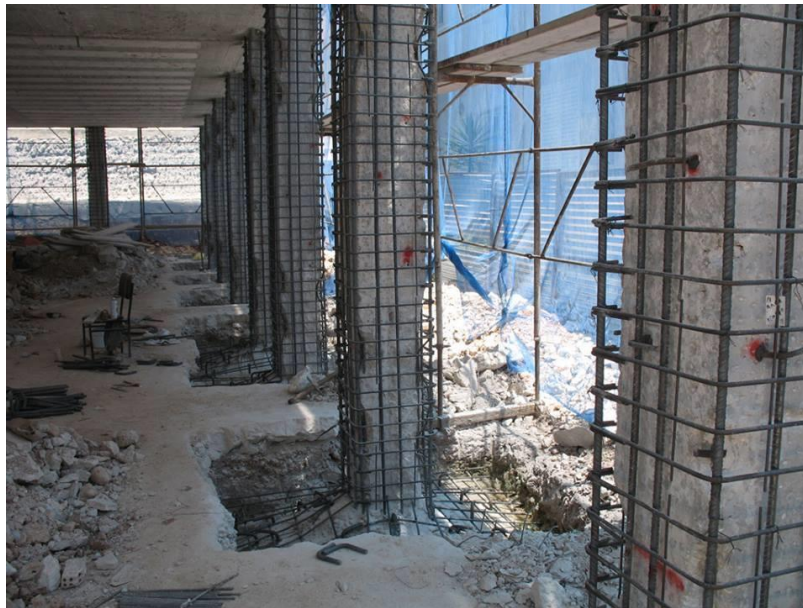
Figure I.9: Chemisage en béton d'un poteau en béton armé
