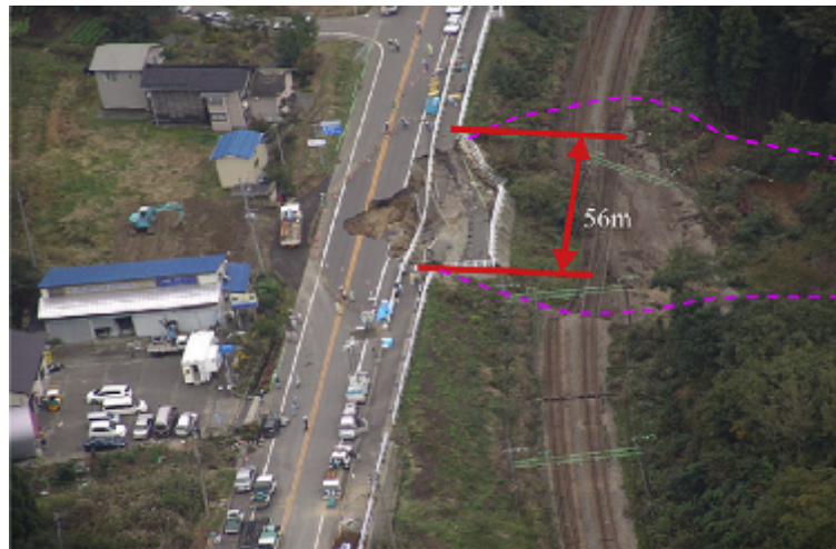
Figure 1. Rupture de l'autoroute de type mur poids et remblai de chemin de fer à Tenno causée par le tremblement de terre Niigataken-Chuetsu 2004
