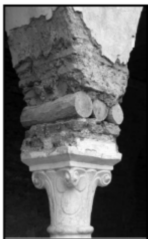
Figure 4 : Détails des chapiteaux de la Colonne avec la présence d'une couche de trois journaux de thuyas insérés entre Les briques maçonnerie.
