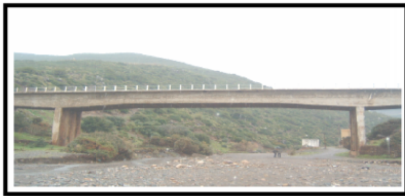
Figure 1. Vue d'ensemble du pont
