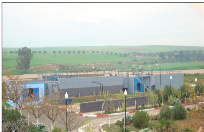
Figure 15 : Présentation du site de prélèvement (STEP), station d'épuration de Sidi Bel Abbès.
