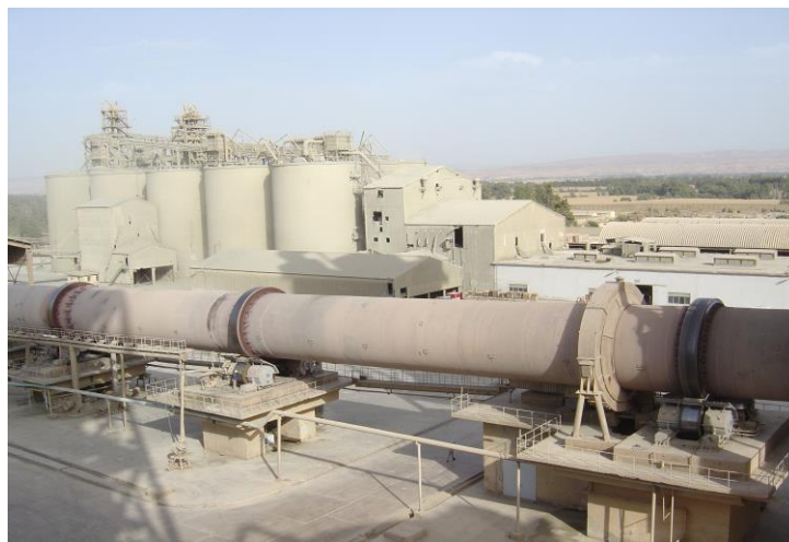
Figure 4.1 : Vue d'ensemble d'une ligne du four de l'ECDE, Chlef
